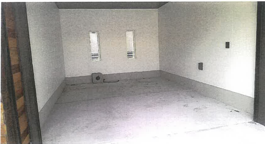
物件 2 車庫内部状況
