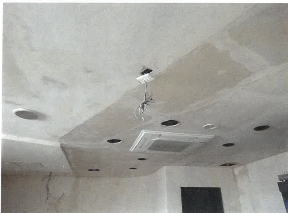
写真56 7階CDE号室内部
