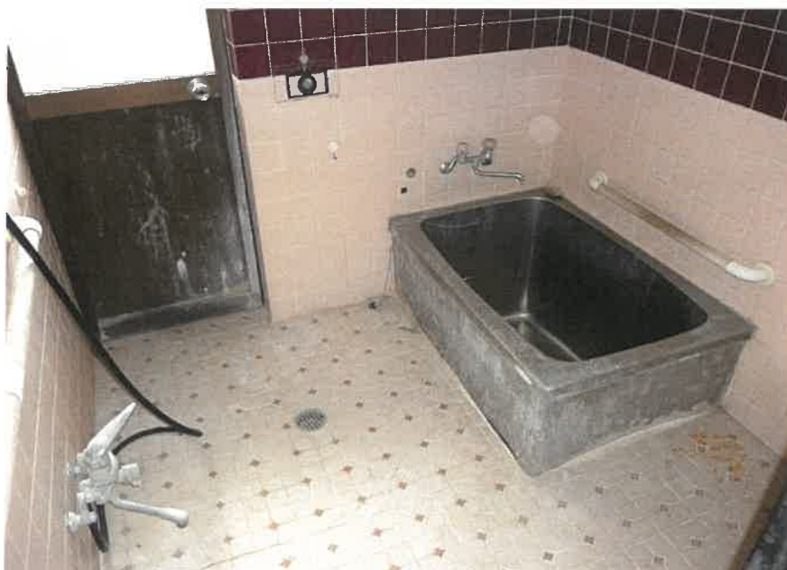
⑪物件2 建物浴室
