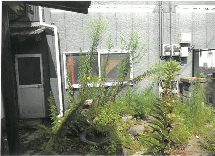
⑦物件 3 建物
