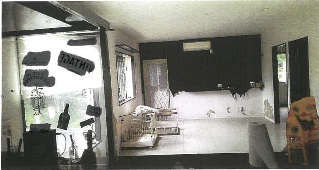
物件 3 2 階内部状況
