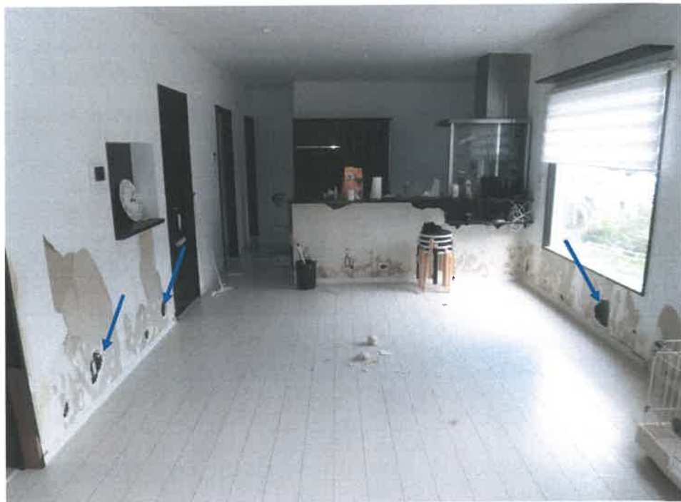
内壁の穴の様子
