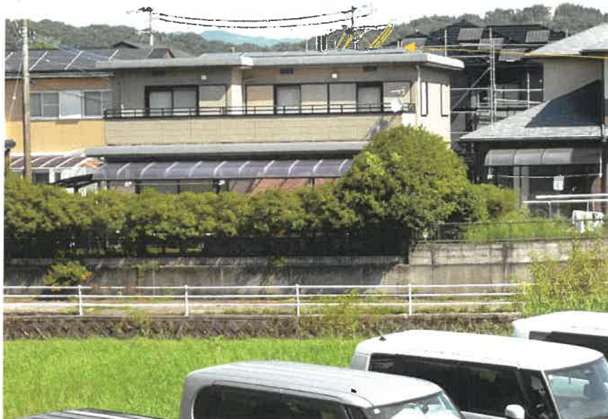
太陽光発電システム
