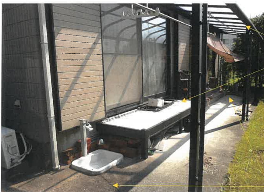
⑥本建物（南西）
