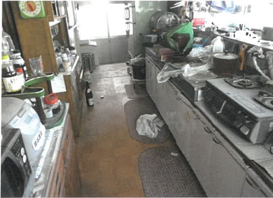
⑩物件 3 主たる建物 台所
