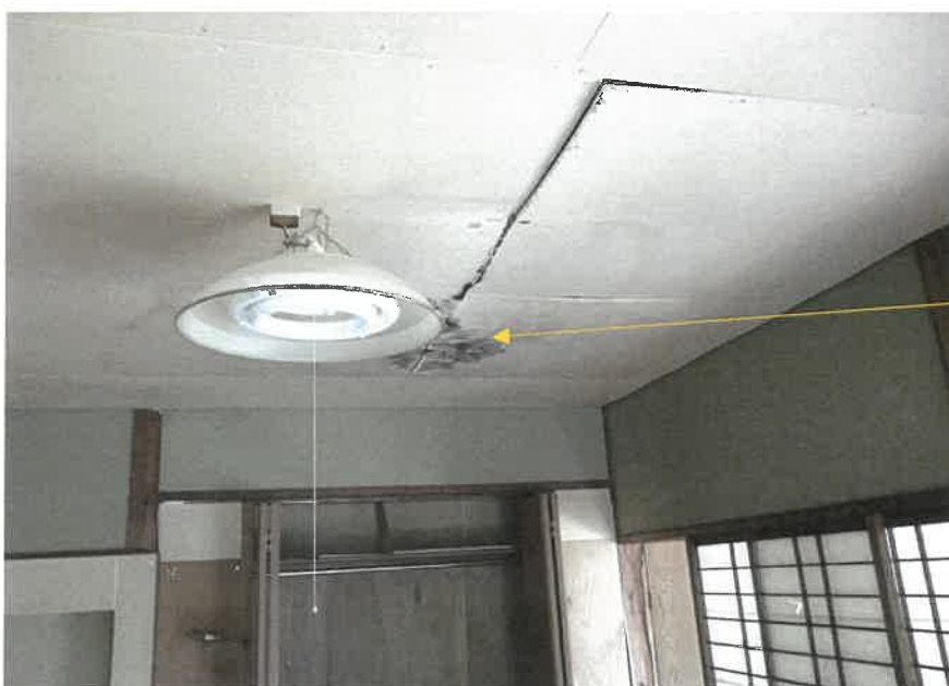
⑨物件 2 主たる建物 洋室天井
