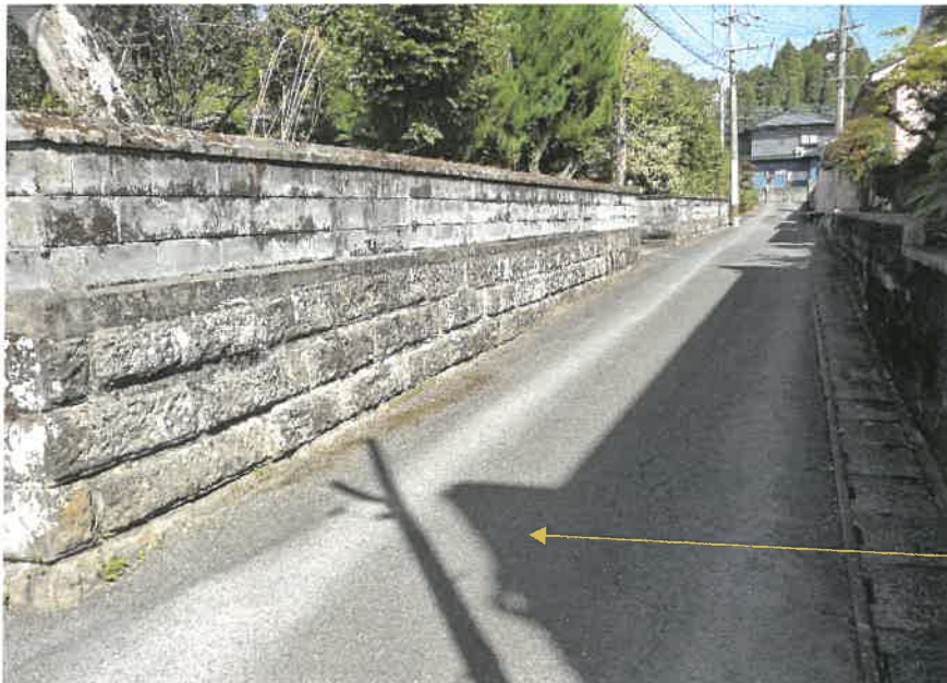
②対象物件（南西→東）
