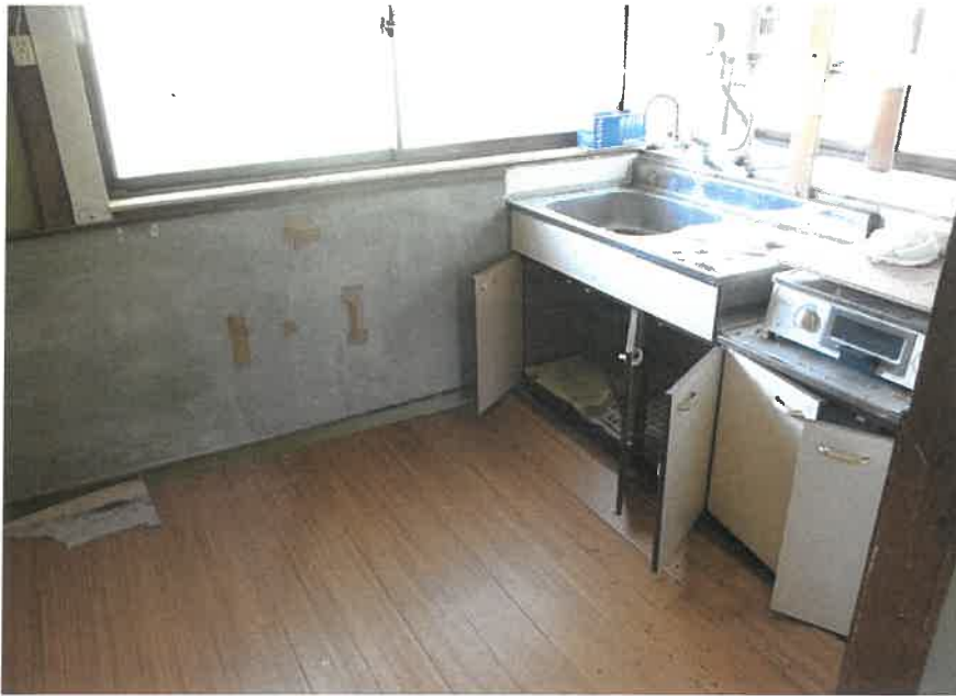
⑩物件 2 主たる建物 台所
