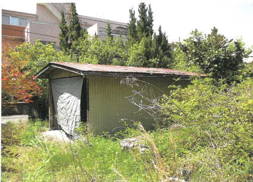
⑫物件 2 附属建物符号 1 (車庫)
