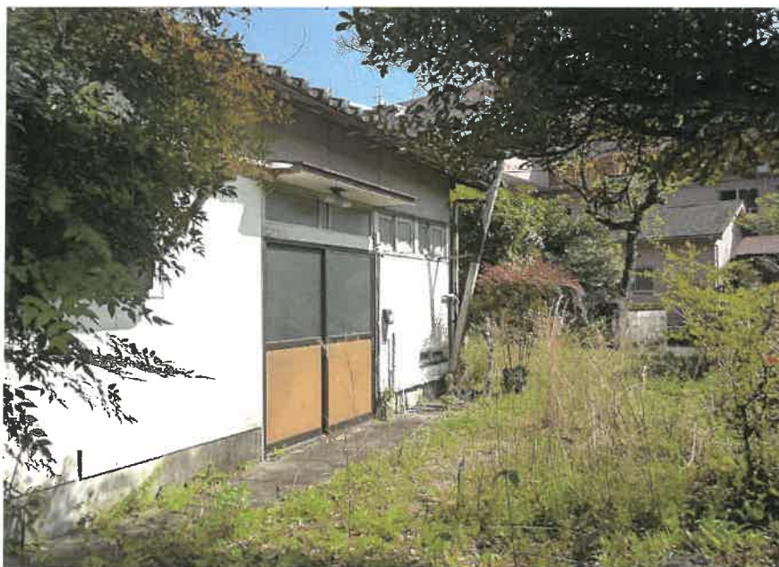
⑧物件 2 主たる建物 （外観）
