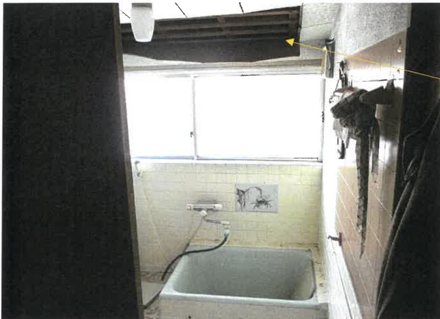
⑪物件 3 主たる建物 浴室
