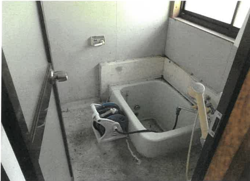
⑪物件 2 主たる建物 浴室
