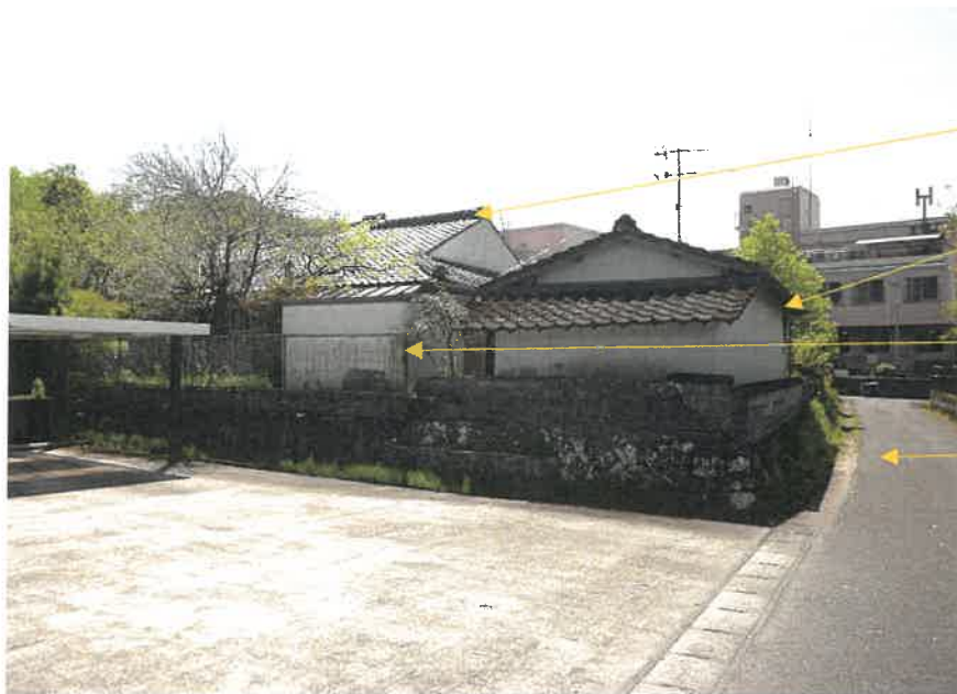
④対象物件（北西→南）
