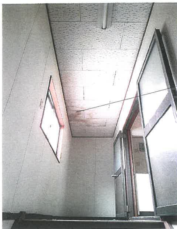
物件 3 2 階内部状況
