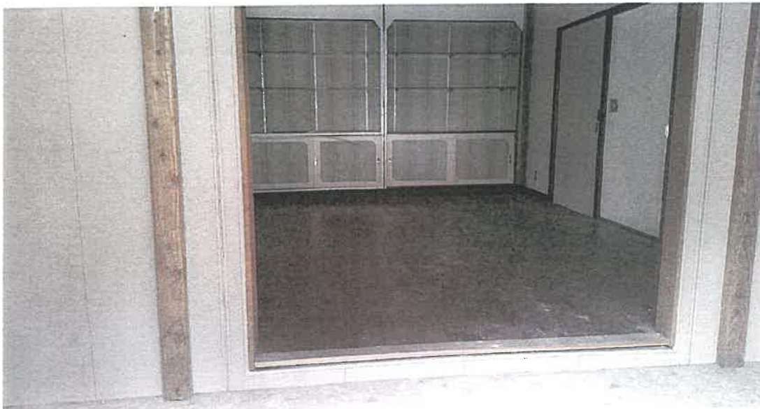
物件 3 1 階内部状況
