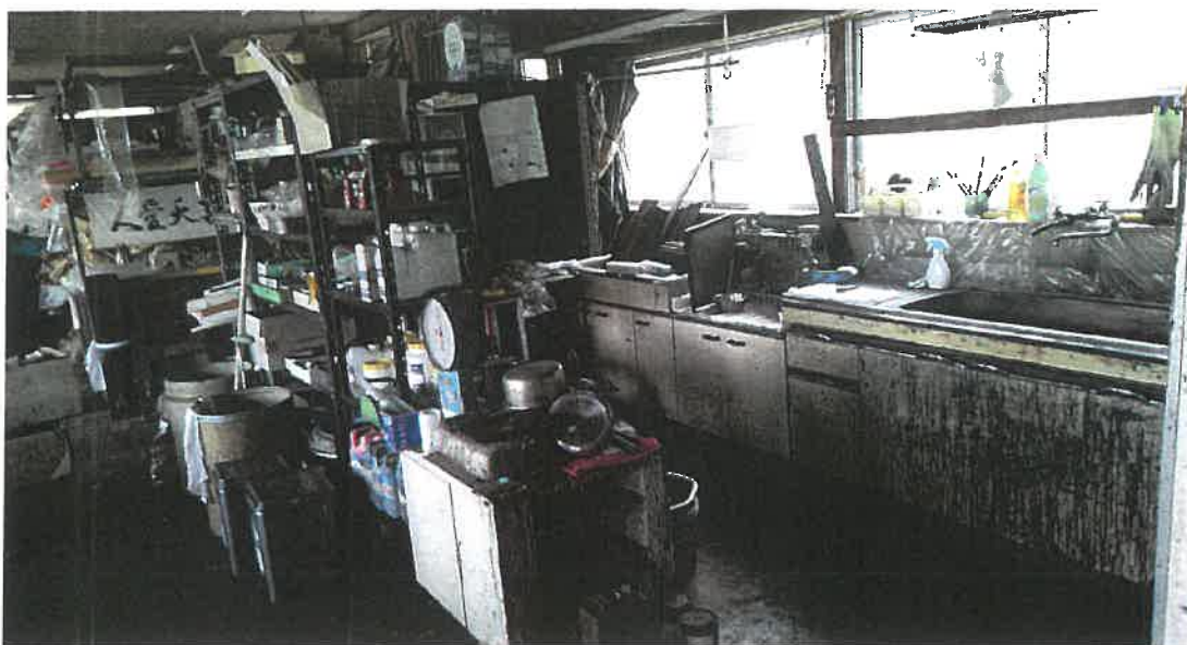
物件 3 1 階内部状況
