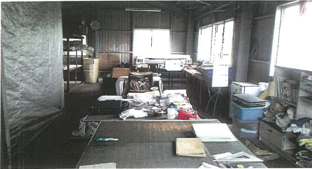
物件 3 2 階内部状況
