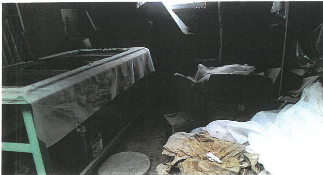
物件 3 未登記附属建物内部状況
