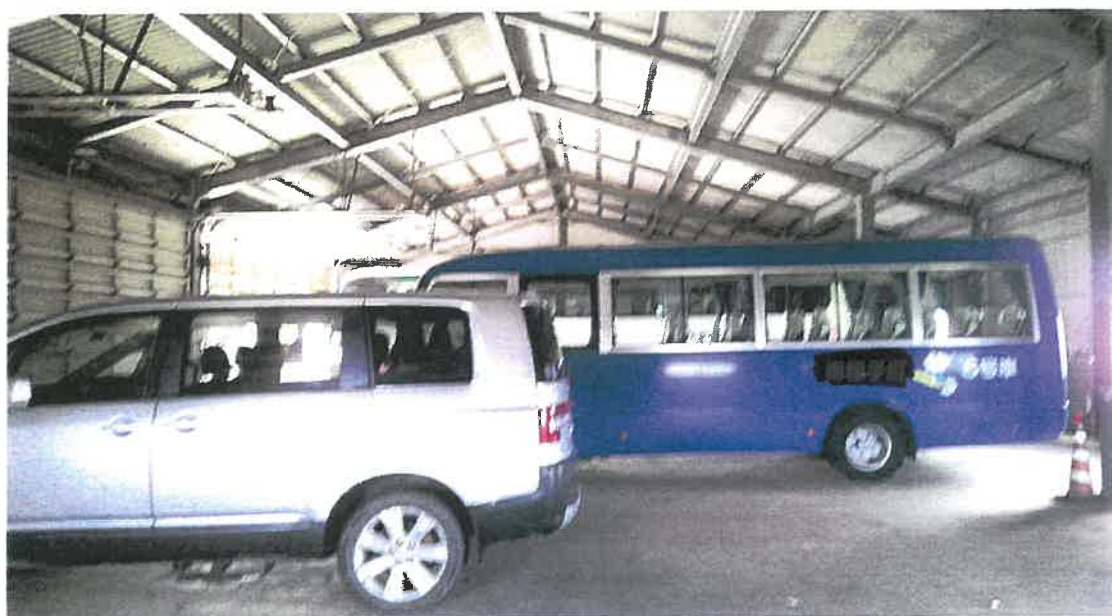
物件8 内部状況
