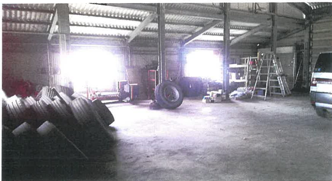
物件8 内部状況
