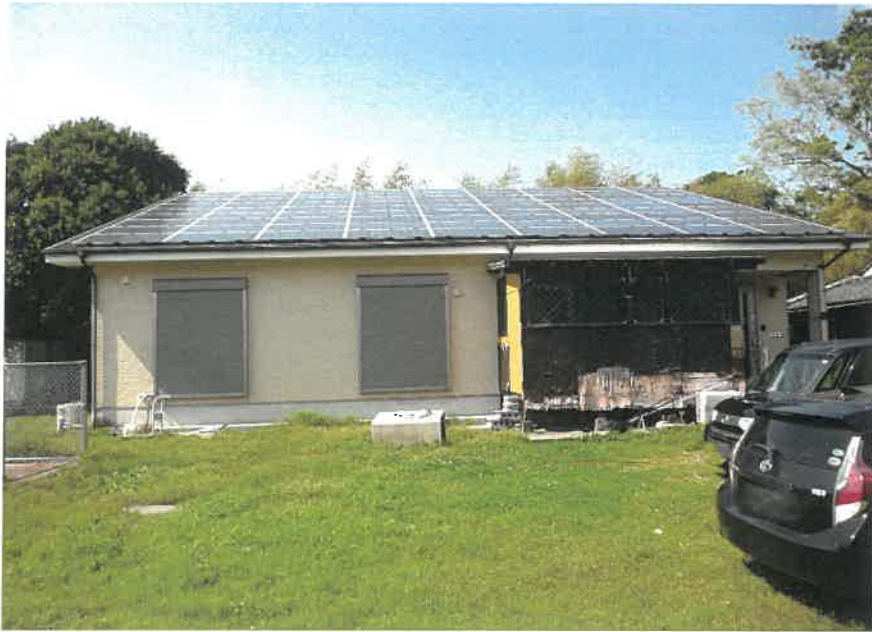
④本建物（南）
