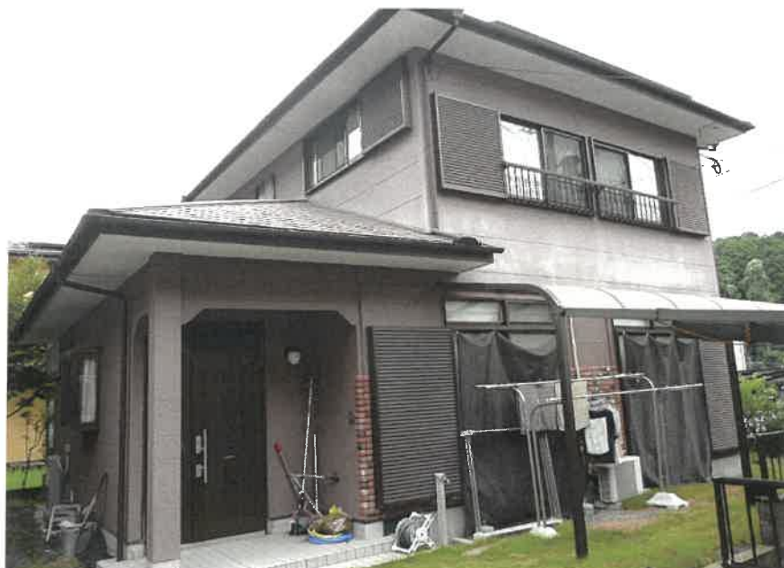
④対象物件（南西）
