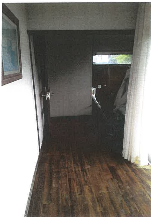
物件 4 内部状況
