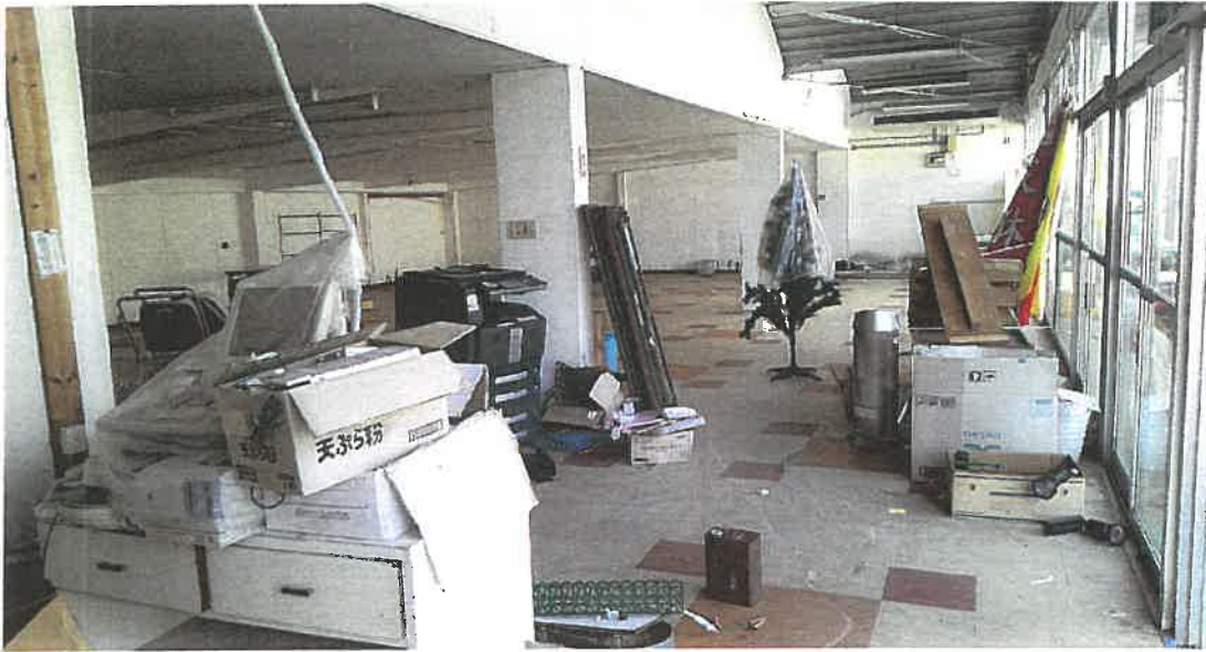
物件 5 内部状況
