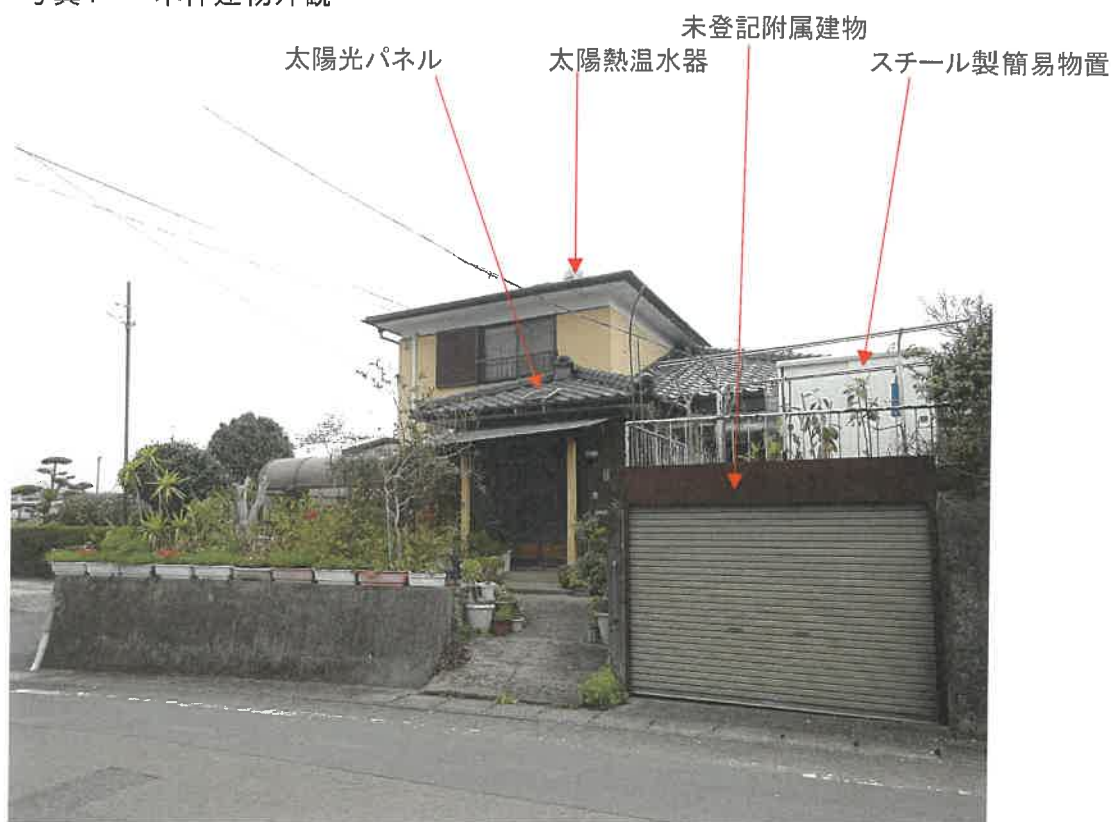
写真1 本件建物外観
