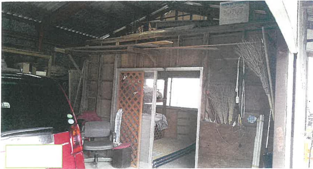
物件 3 内部状況
