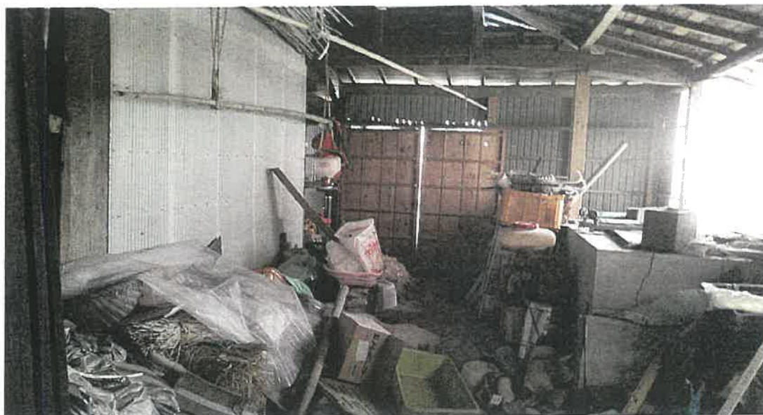
物件5 内部状況
