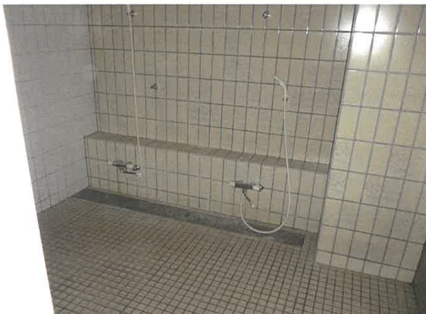
⑨ 2階テナント シャワー室
