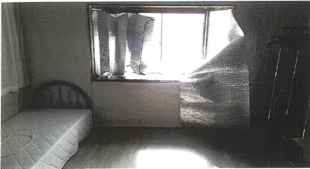
物件 2 内部状況
