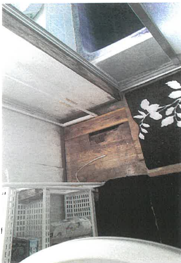
物件 2 内部状況
