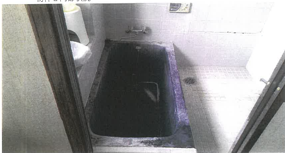
物件 2 内部状況
