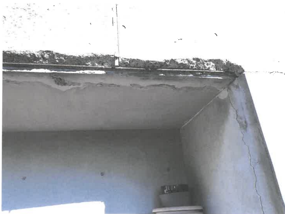
コンクリート壁の状況
