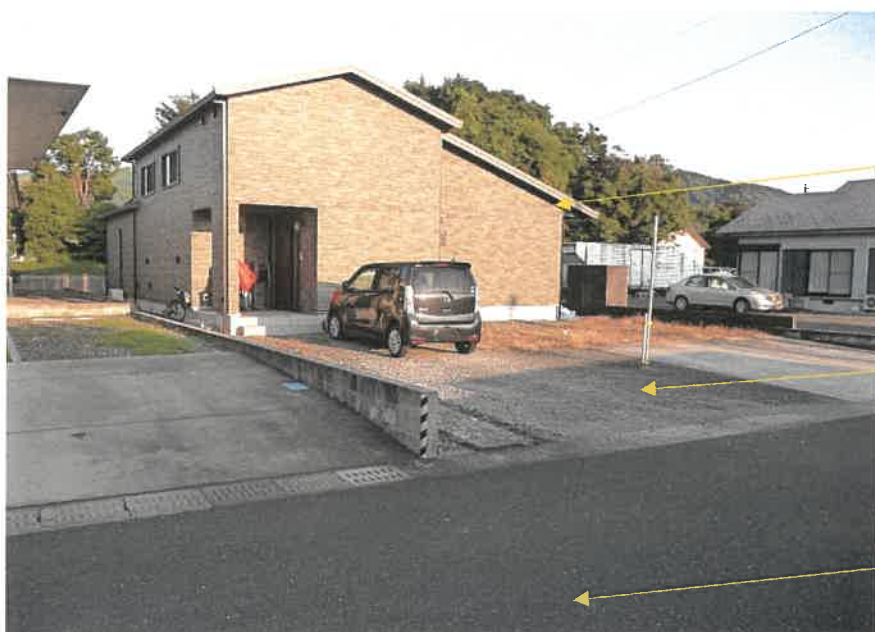
③対象物件（北西）
