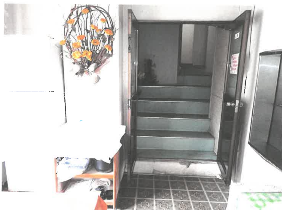
物件4 増築部分（通路階段）
