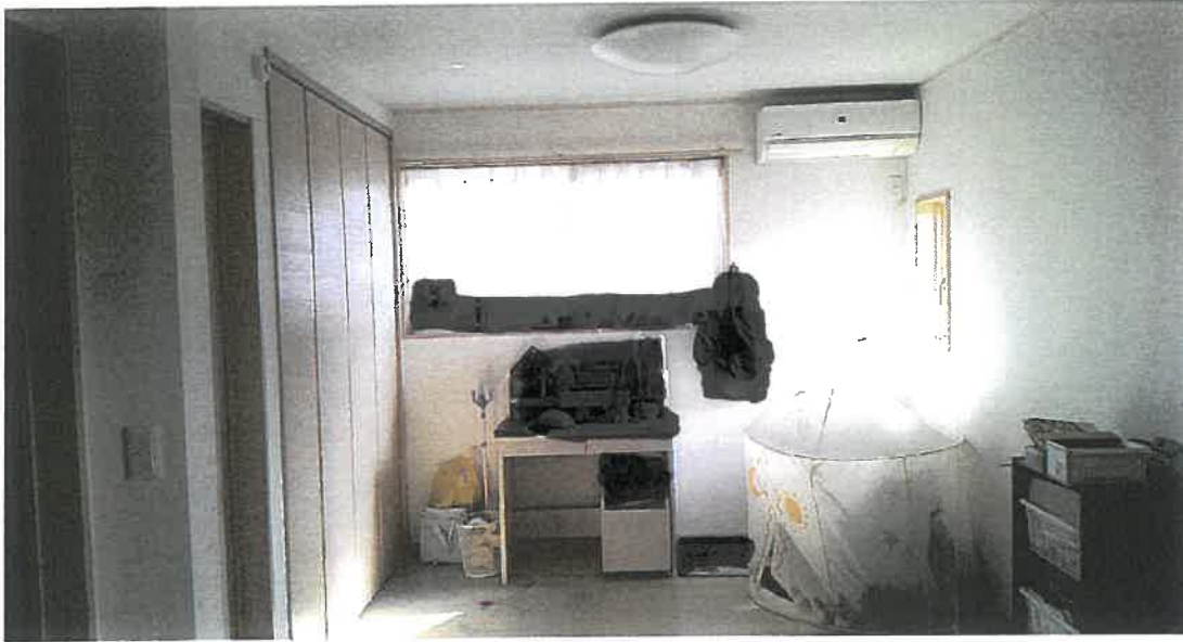
物件 2 2 階内部状況
