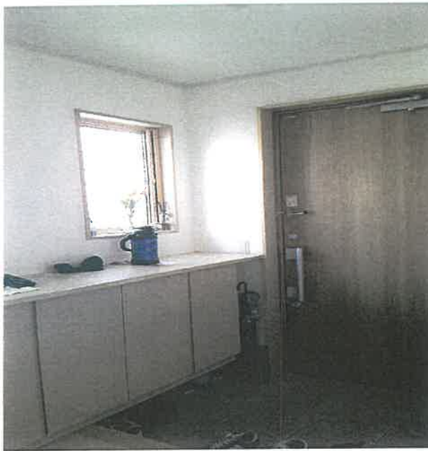
物件 2 1 階内部状況
