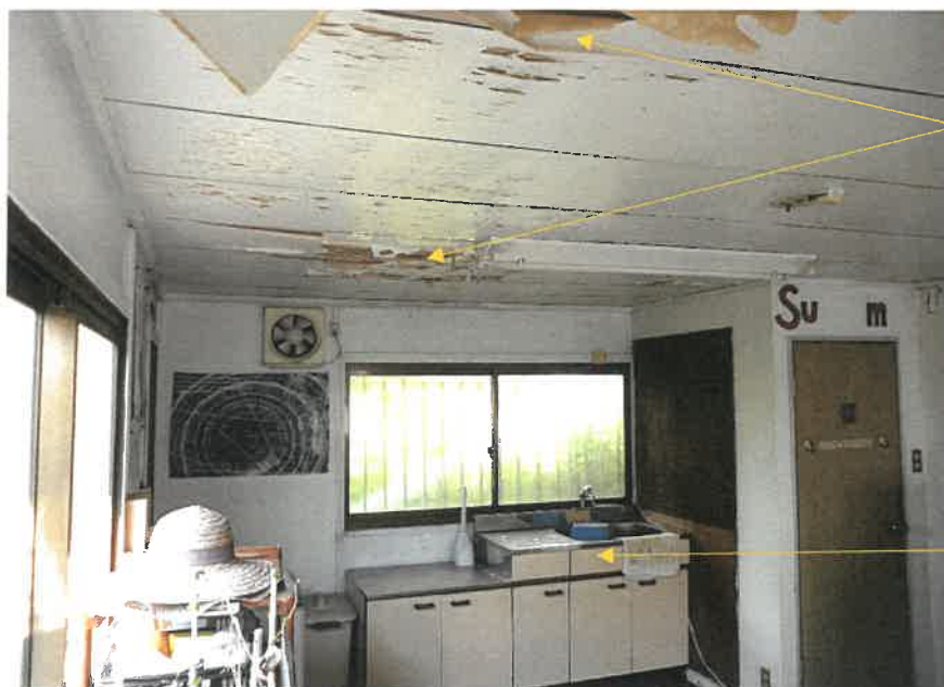
⑧本建物（西方向）
