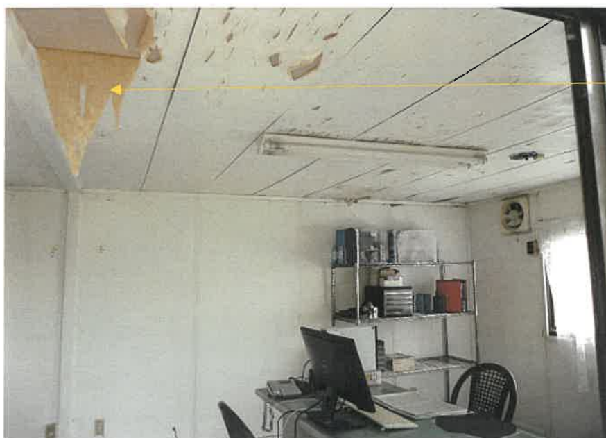
⑫本建物（東方向）天井
