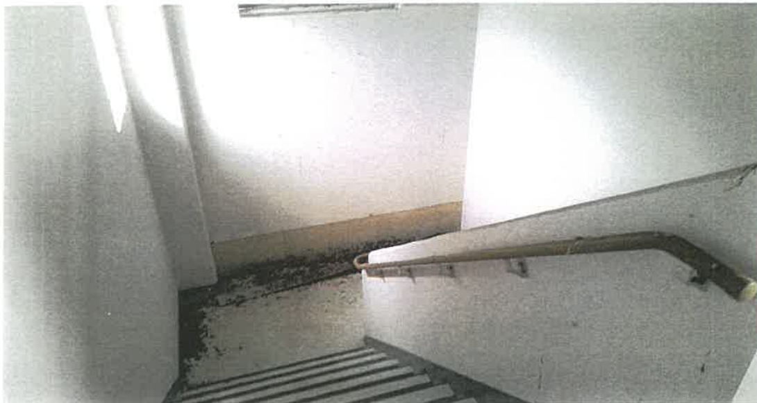
物件3 7階階段状況
