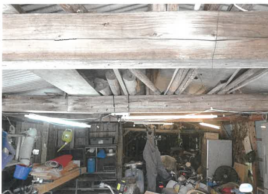
⑫ 附属建物のさしかけ （内部）
