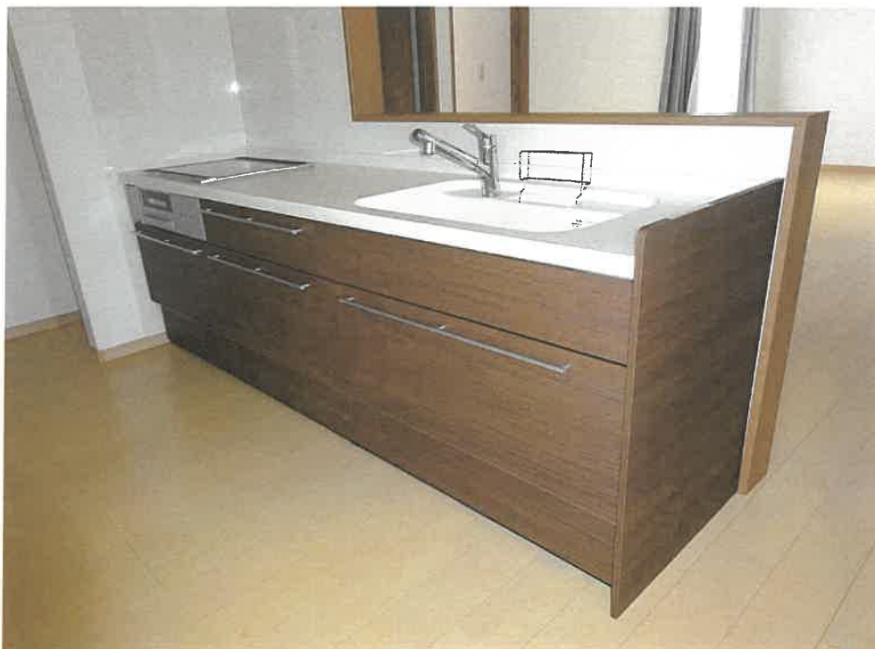
写真6 エアコン撤去後の跡
