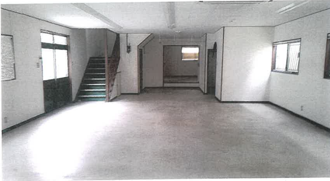
物件3 1階内部状況
