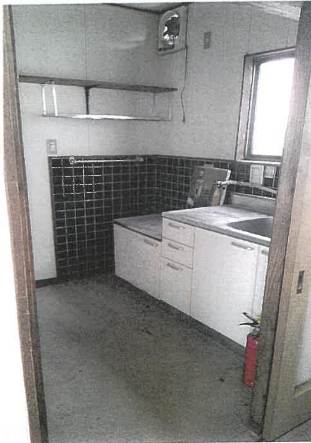
物件3 1階内部状況
