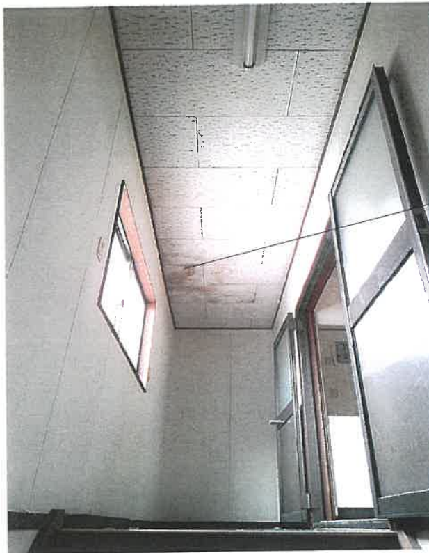
物件3 2階内部状況
