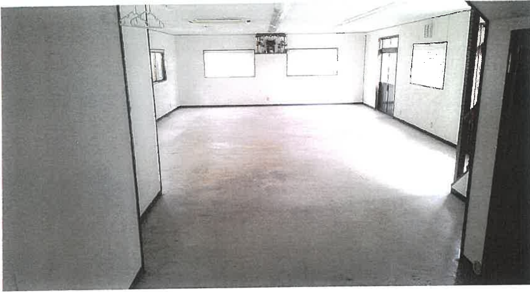
物件3 1階内部状況
