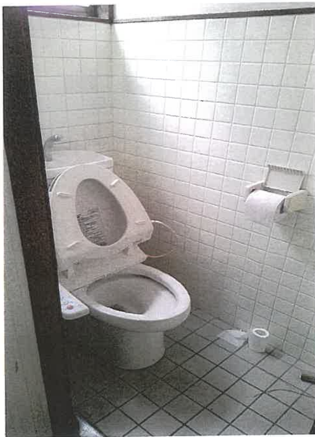
物件3 1階内部状況
