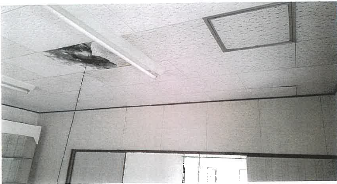
物件3 1階内部状況
