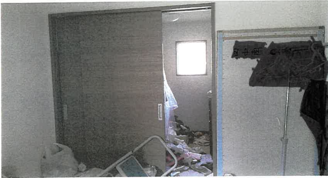
物件2 内部状況
