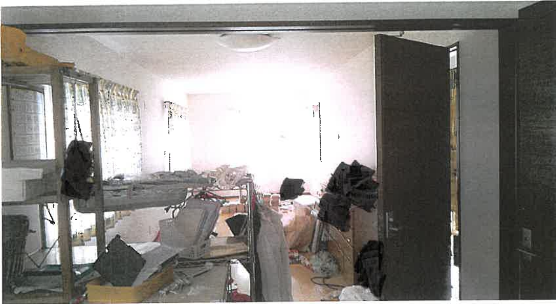
物件2 内部状況
