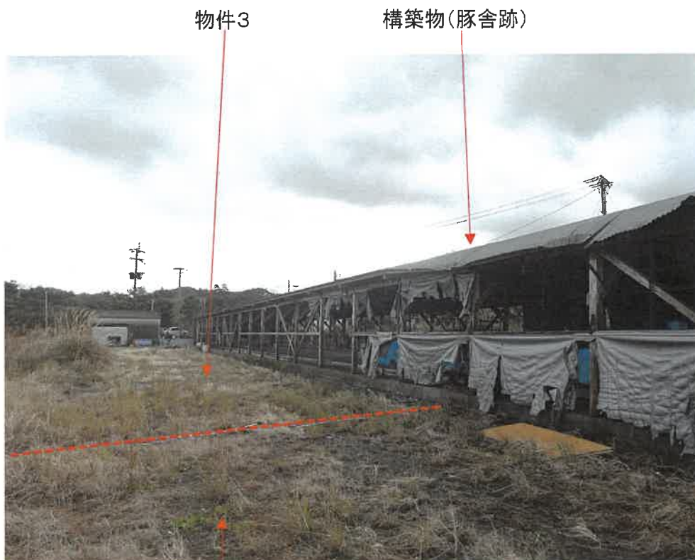
写真7 物件3と1895番に跨がって存する構築物(豚舎跡)の状況
