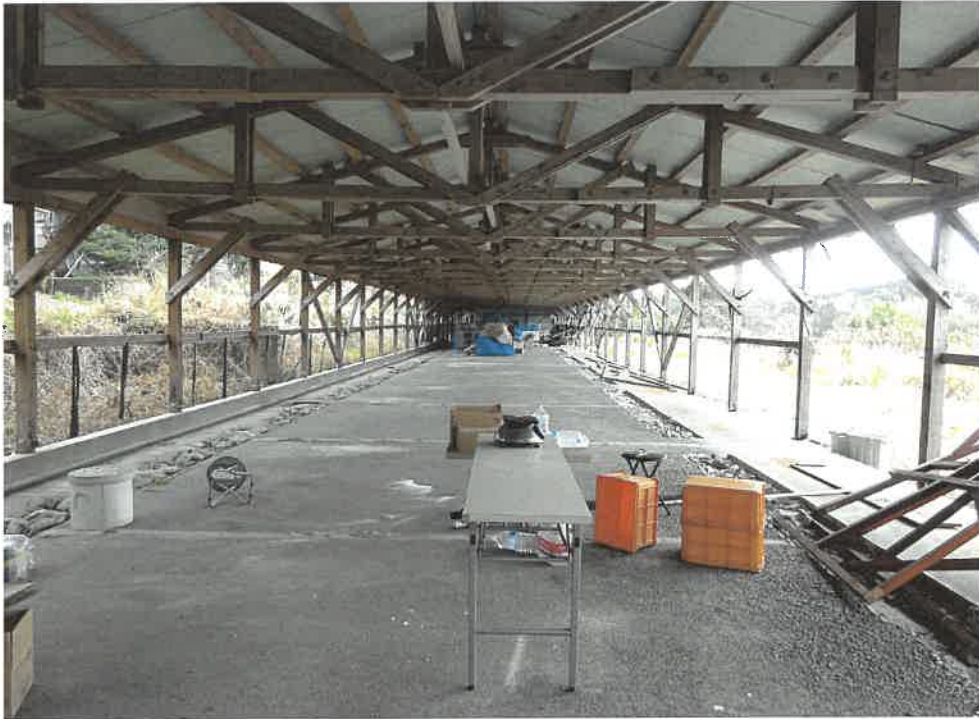
写真10 物件3と1895番に跨がって存する構築物(豚舎跡)の状況
