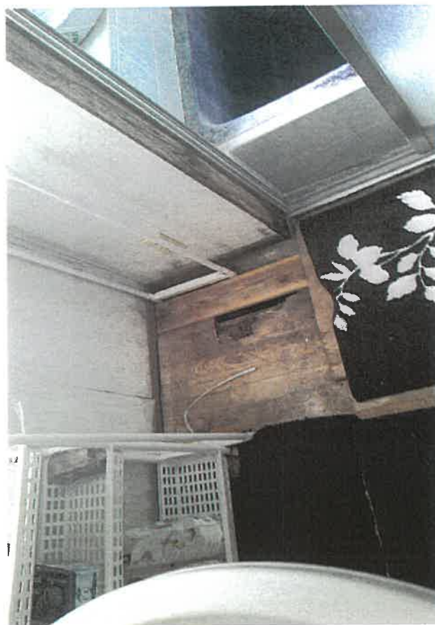
物件2 内部状況
