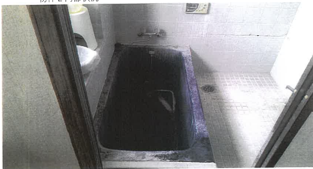
物件2 内部状況
