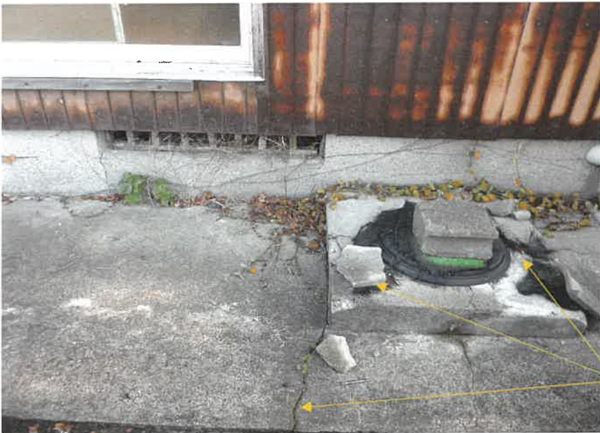
⑧物件 7 基礎・犬走り
