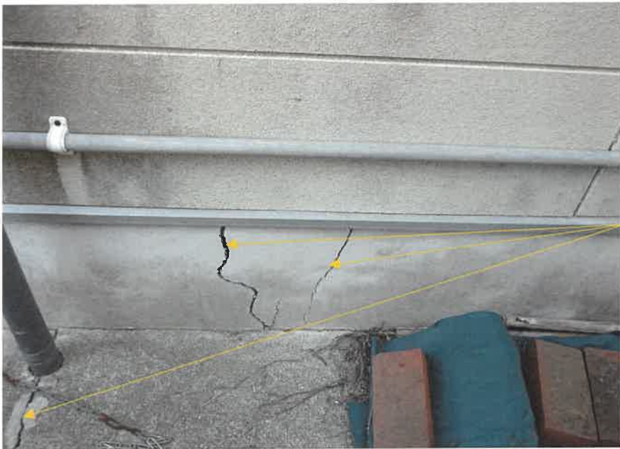
⑤物件 3 基礎・犬走り
