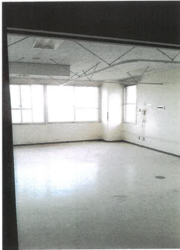
物件3 3階内部状況
