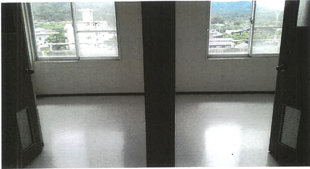
物件 3 3 階内部状況
