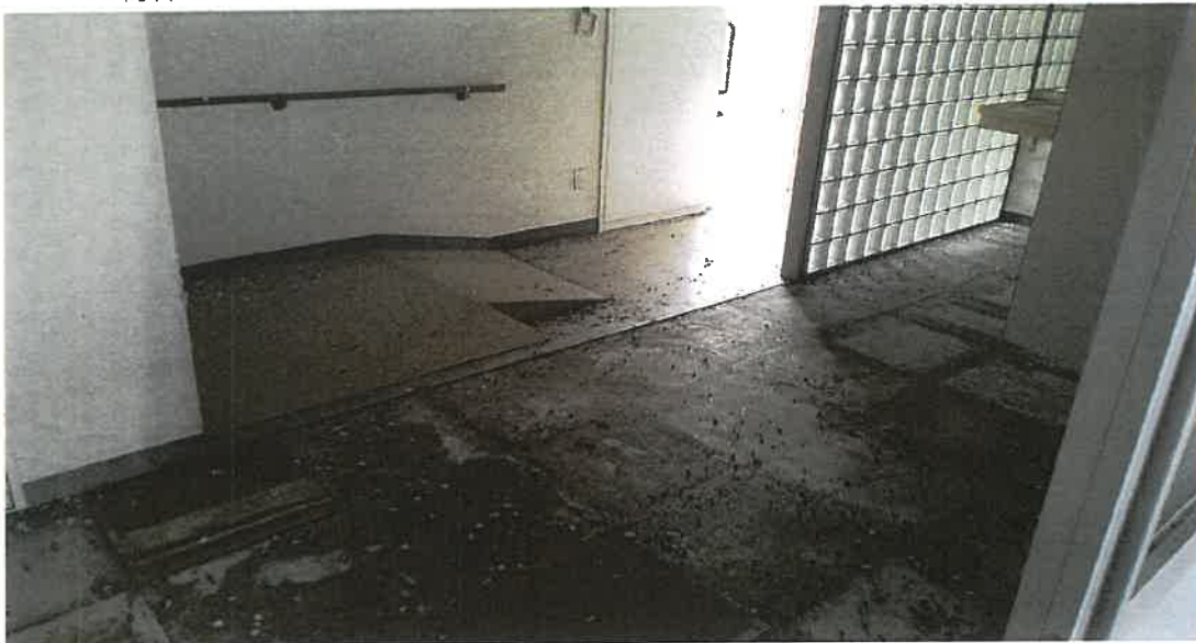
物件3 6階内部状況
