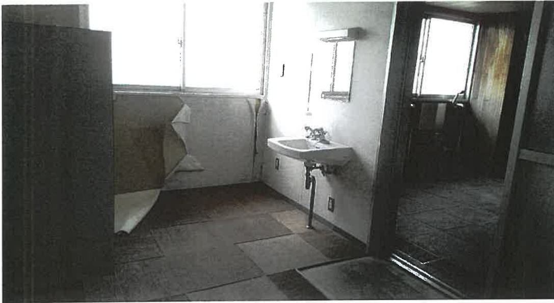
物件3 3階内部状況
