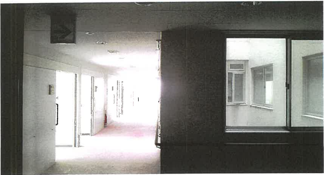
物件 3 3 階内部状況
