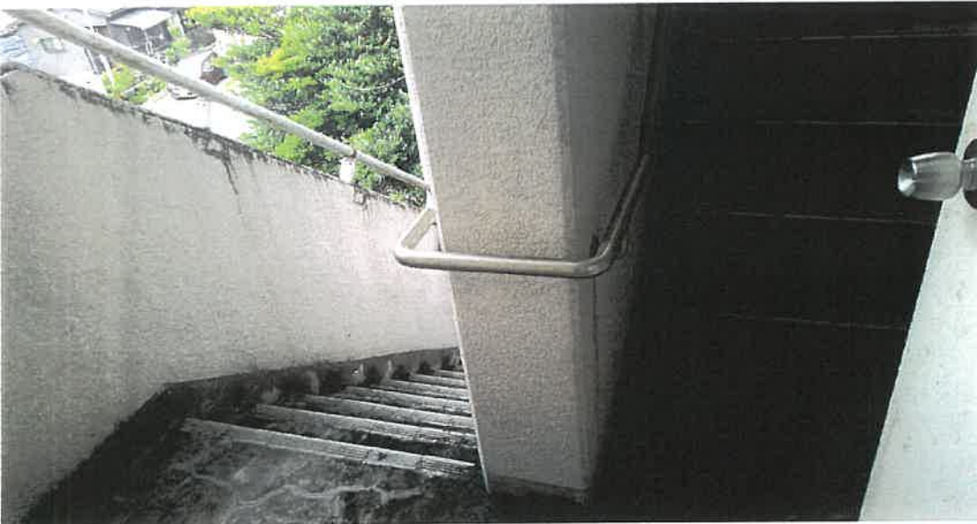
物件 3 3 階内部状況
