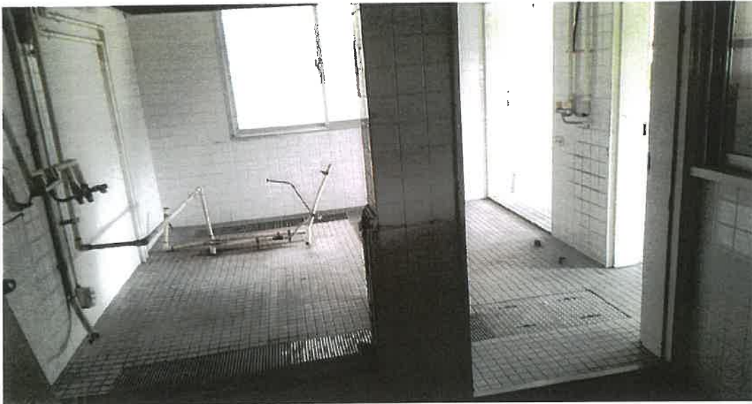
物件 3 5 階内部状況
