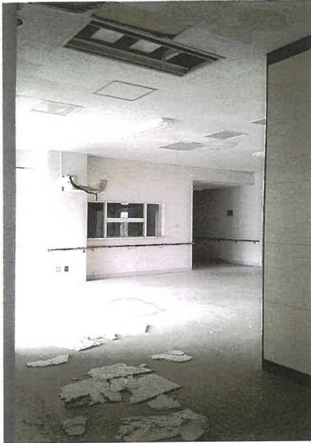
物件3 1階内部状況
