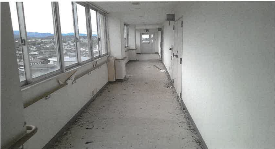
物件 3 6階内部状況
