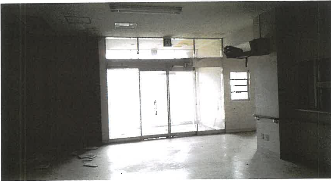
物件3 1階内部状況
