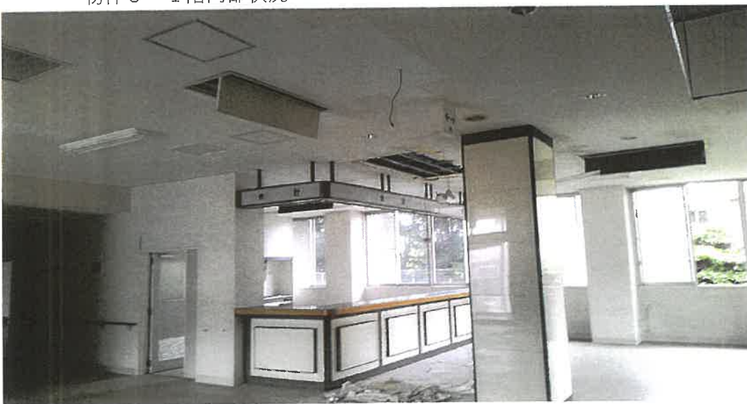
物件3 1階内部状況
