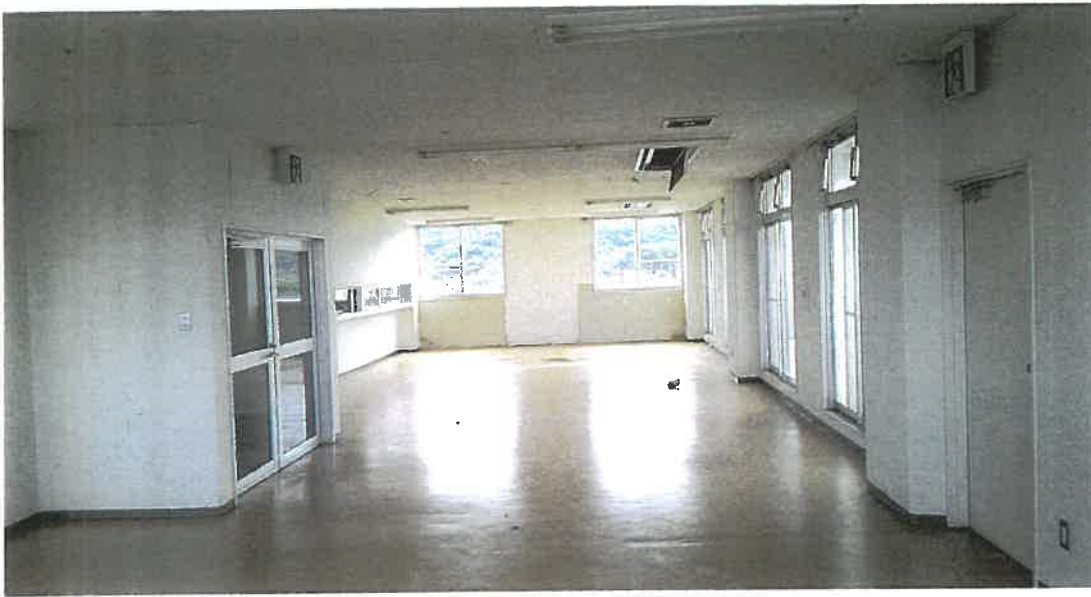
物件 3 5 階内部状況
