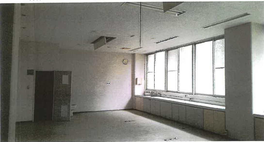
物件3 1階内部状況
