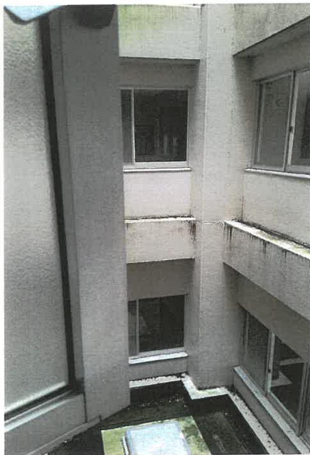
物件3 3階内部状況
