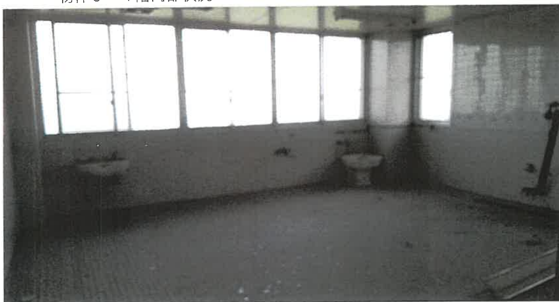
物件3 4階内部状況
