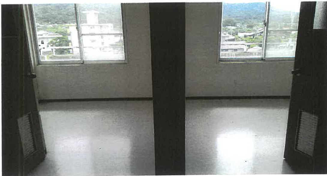
物件 3 3 階内部状況
