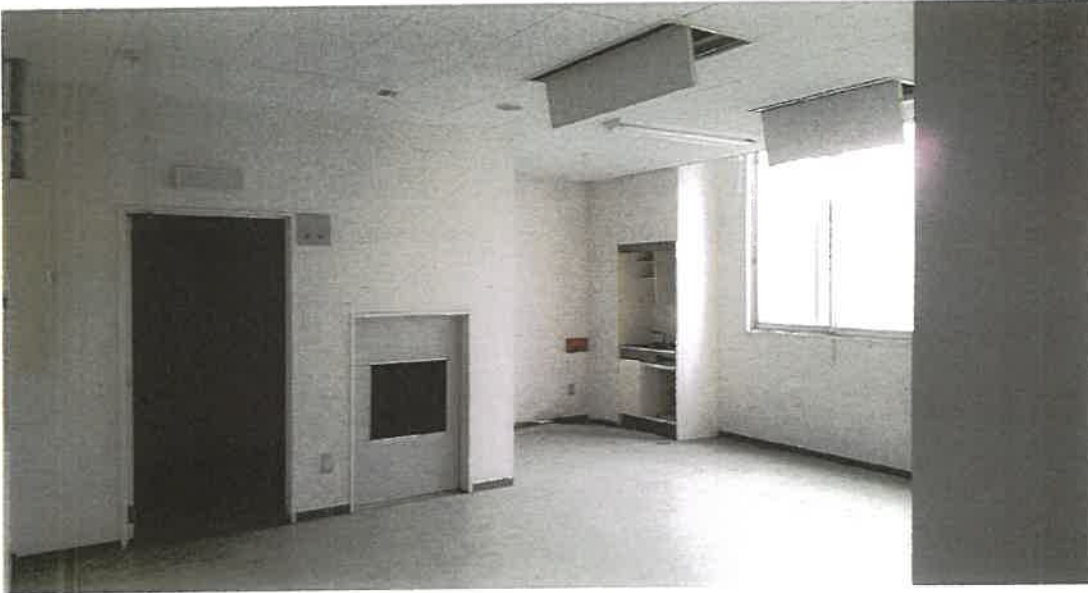
物件 3 1 階内部状況
