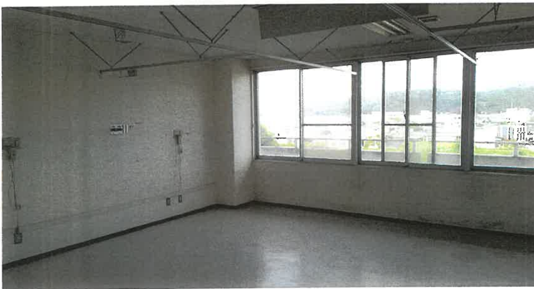
物件3 3階内部状況
