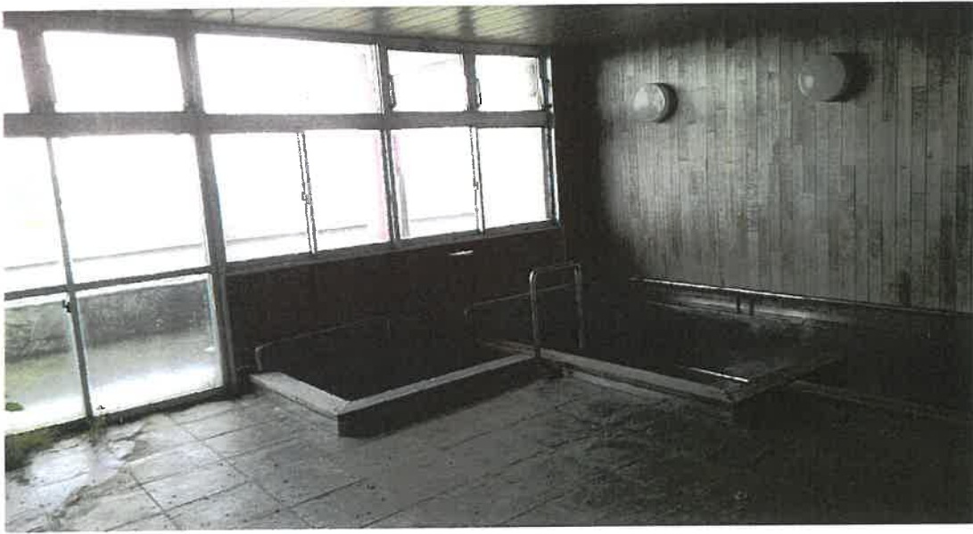
物件3 6階内部状況
