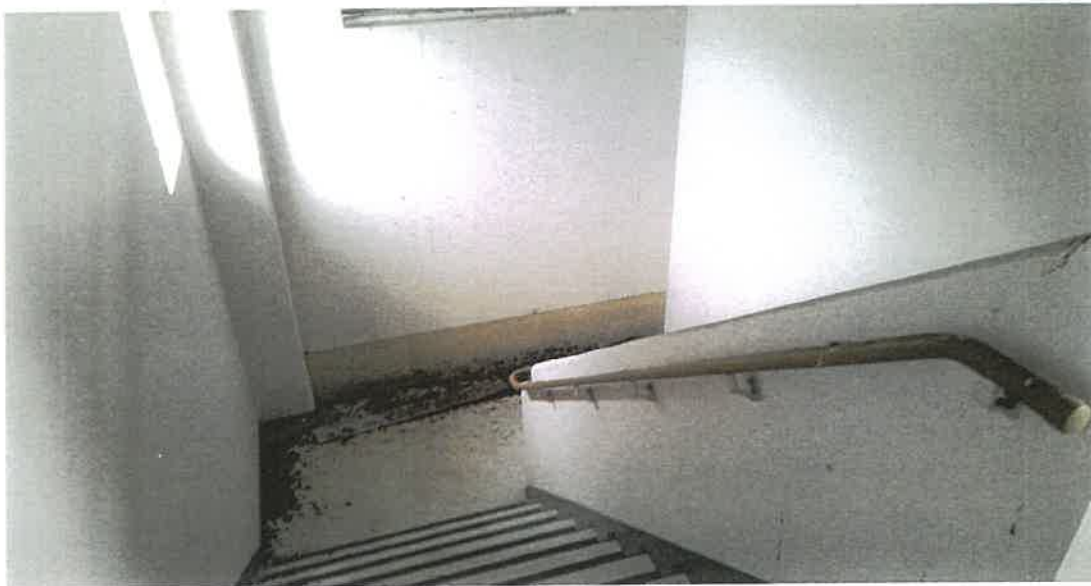
物件3 7階階段状況
