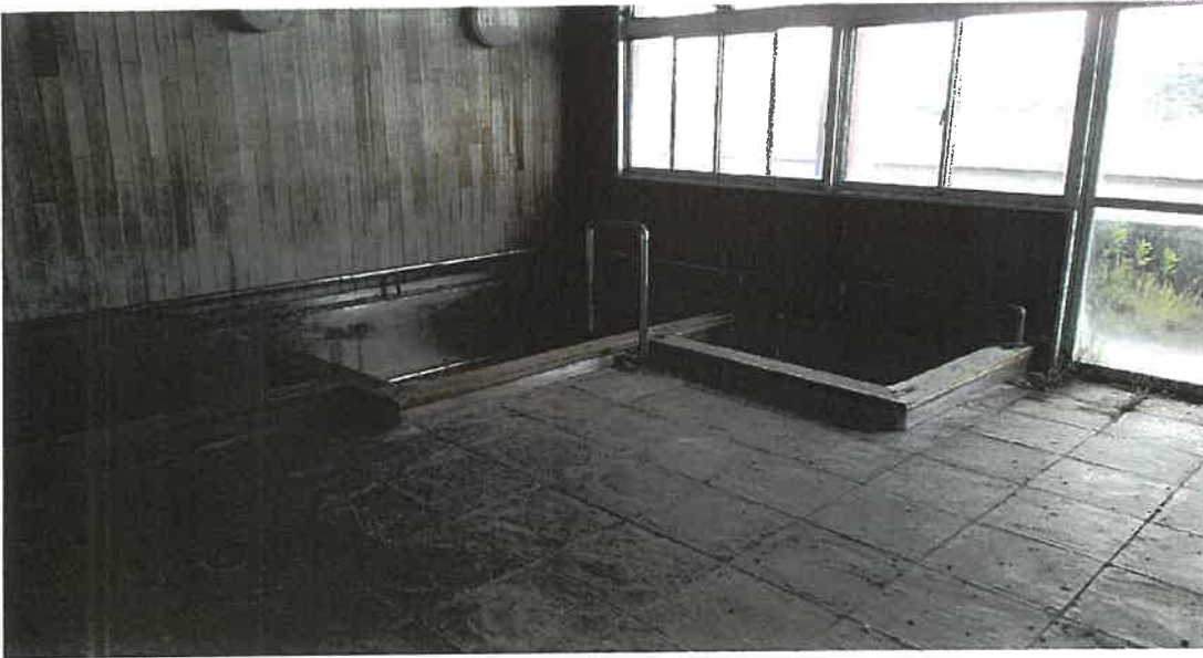
物件3 6階内部状況
