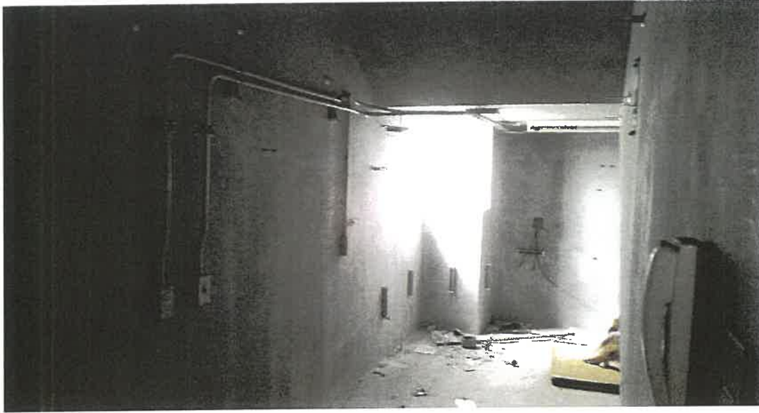
物件3 2階内部状況
