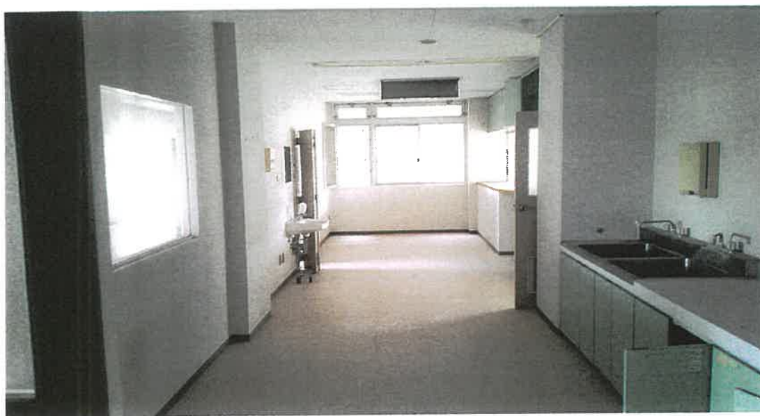
物件 3 3 階内部状況
