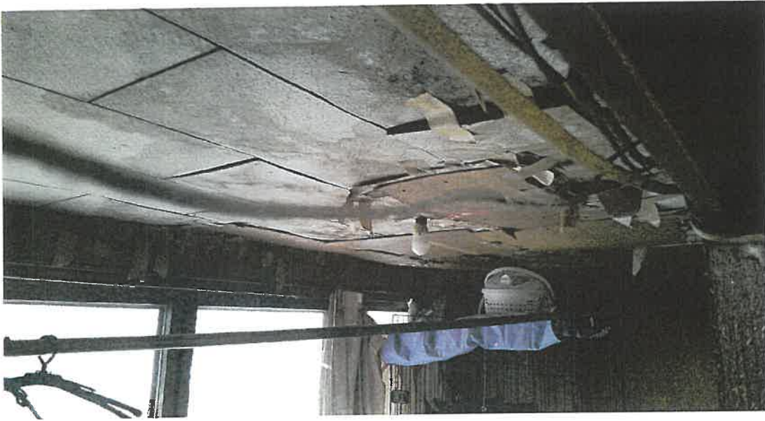
物件 2 内部状況
