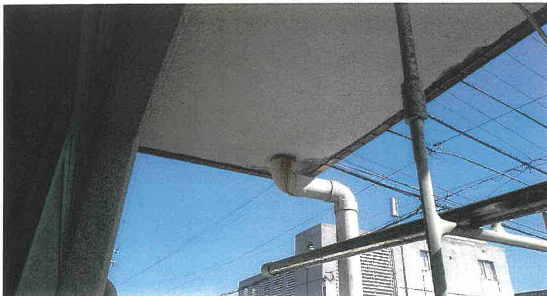
物件2 101号室のベランダの庇の状況
