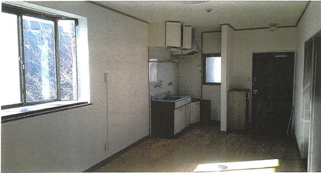
物件 2 206号室内部状況
