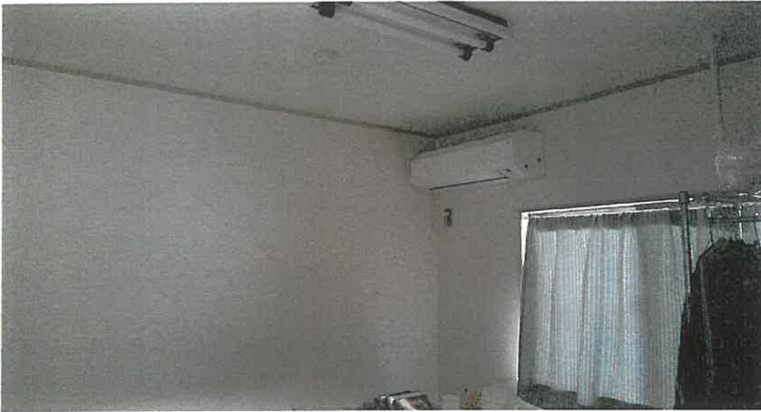
物件 2 103号室 内部状況
