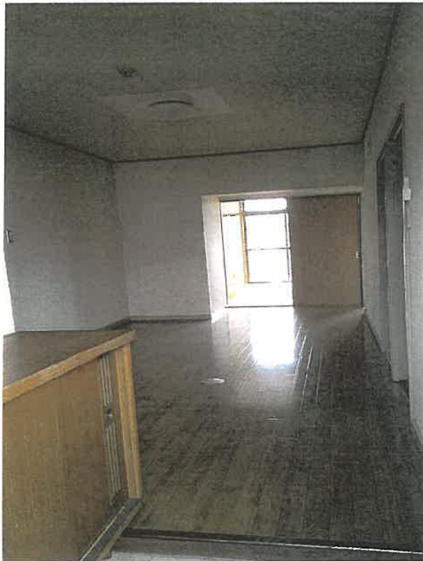
物件 2 2 0 5 号室内部状況
