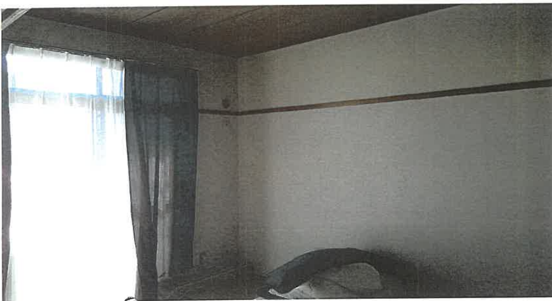
物件2 101号室内部状況
