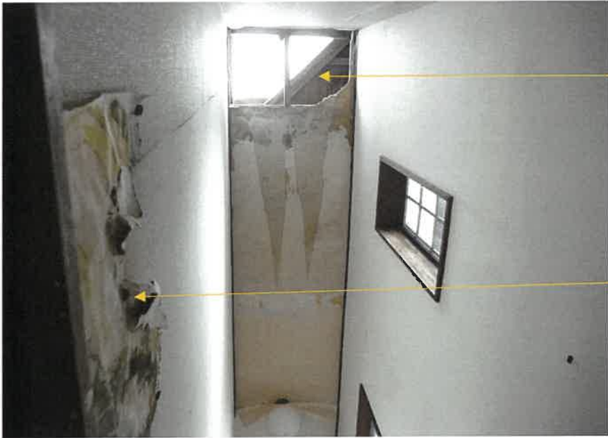
⑧階段天井
