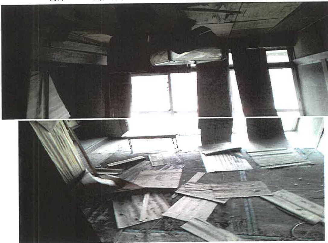
物件3 1階内部状況
