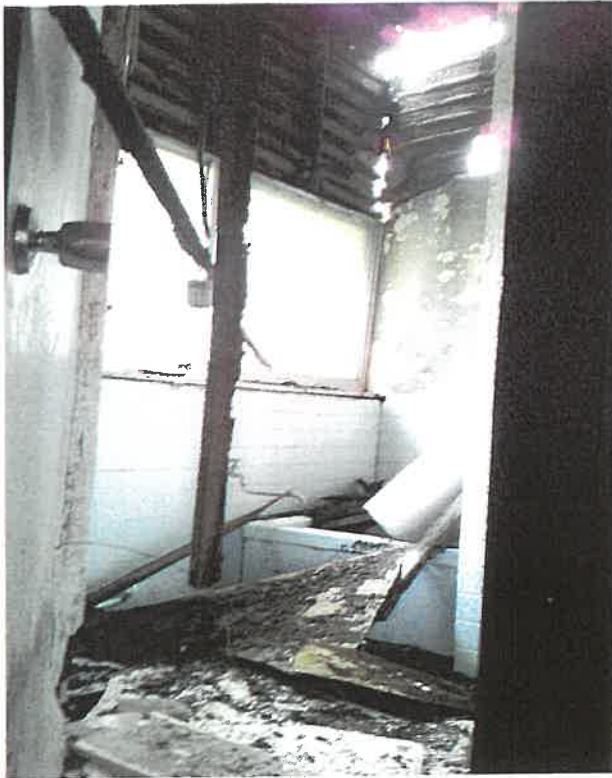
物件3 1階内部状況
