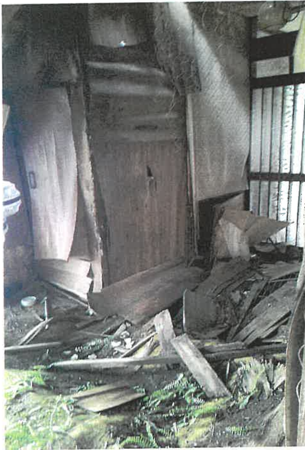
物件3 1階内部状況
