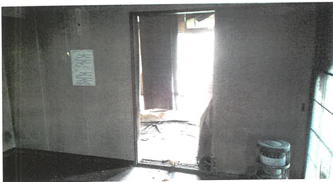
物件3 1階内部状況
