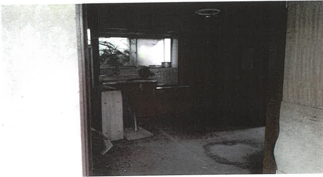
物件3 1階内部状況
