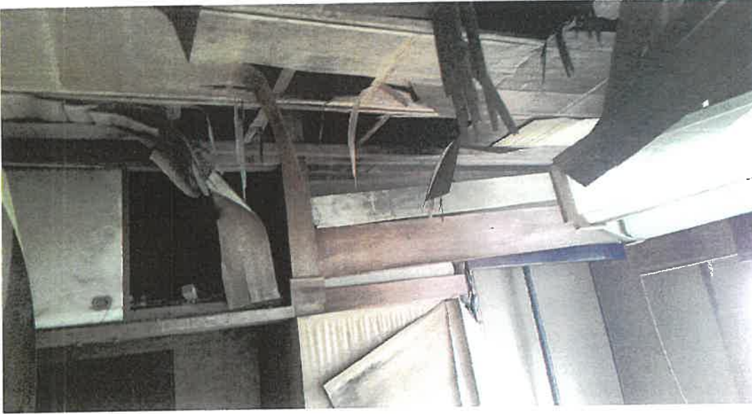
物件3 1階内部状況
