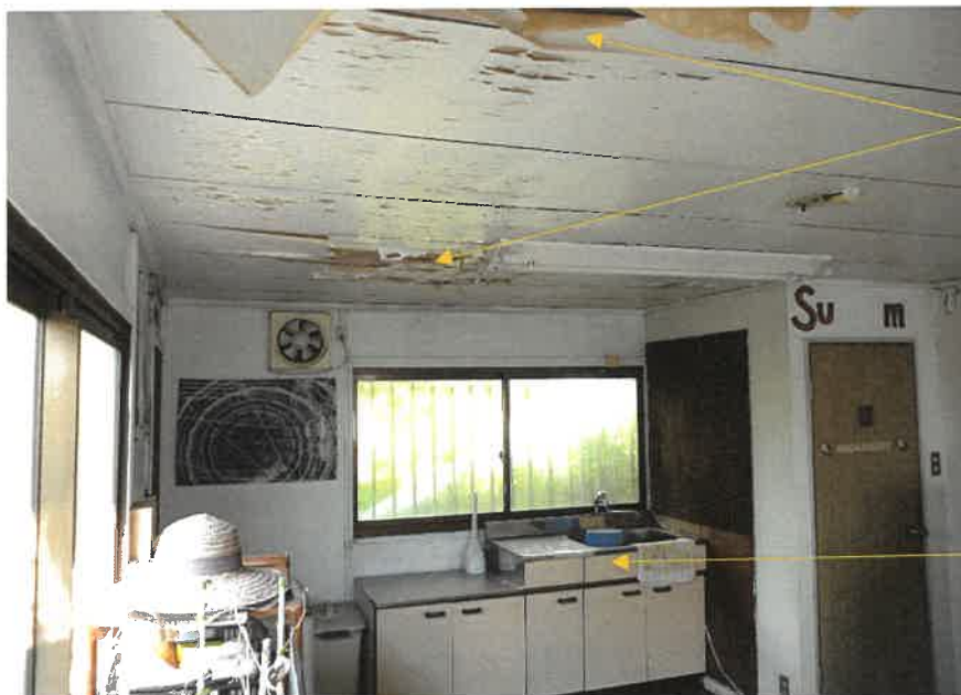
⑧本建物（西方向）
