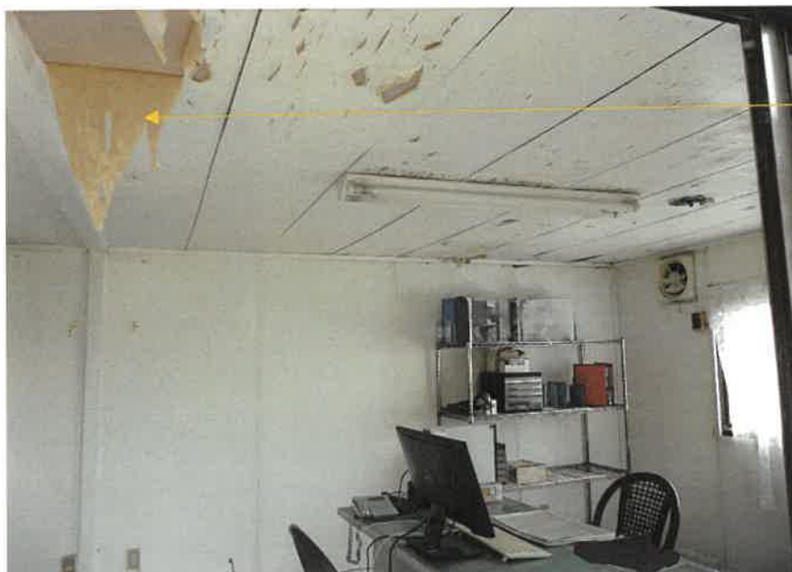
⑫本建物（東方向）天井
