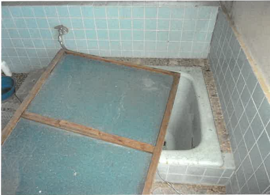
⑬未登記附属建物浴室
