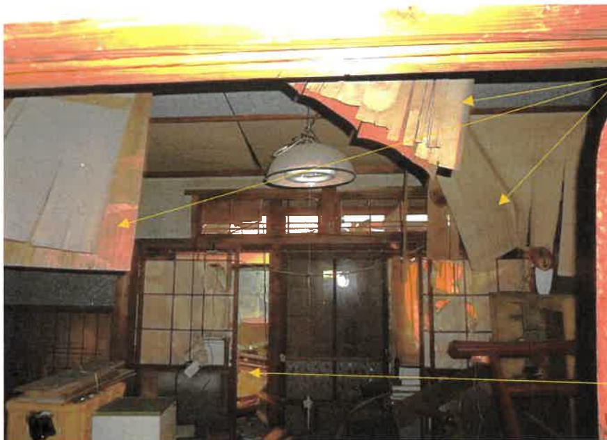
⑭未登記附属建物室内
