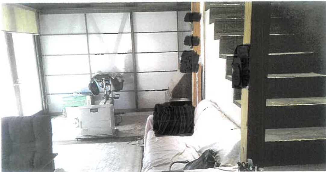
物件4 1階内部商況
