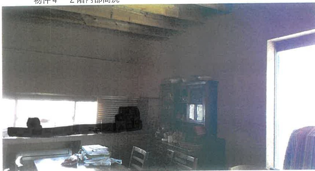
物件4 2階内部商況
