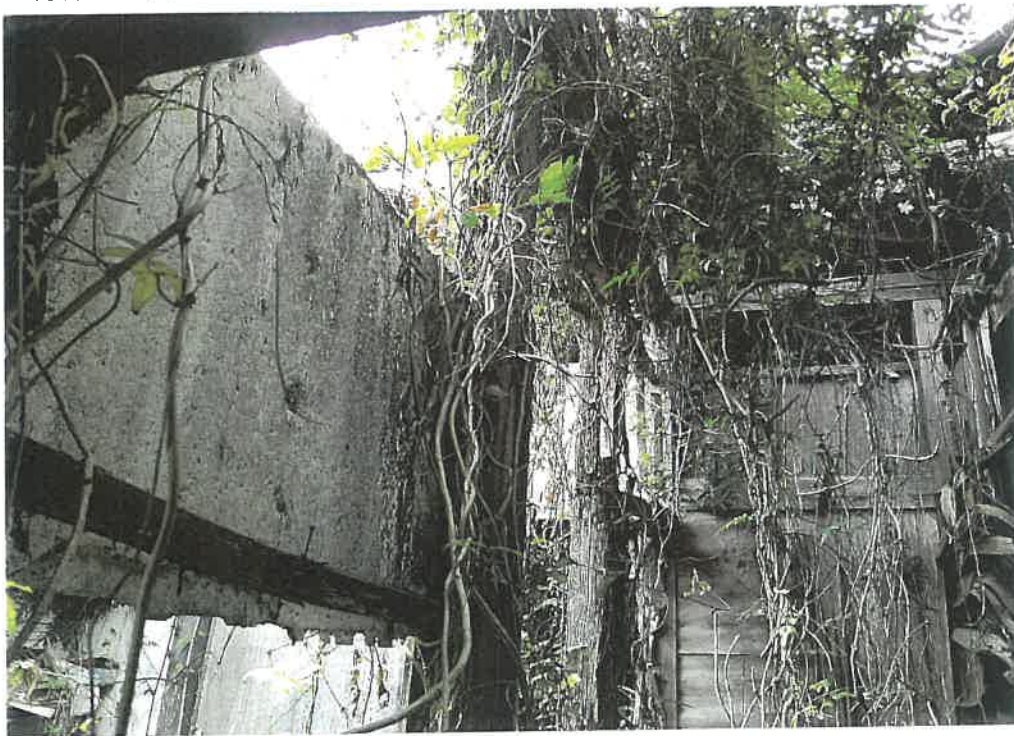
物件 2 内部状況
