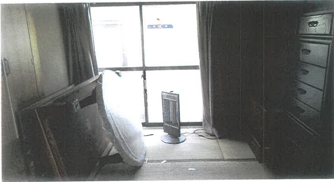
物件 2 内部状況
