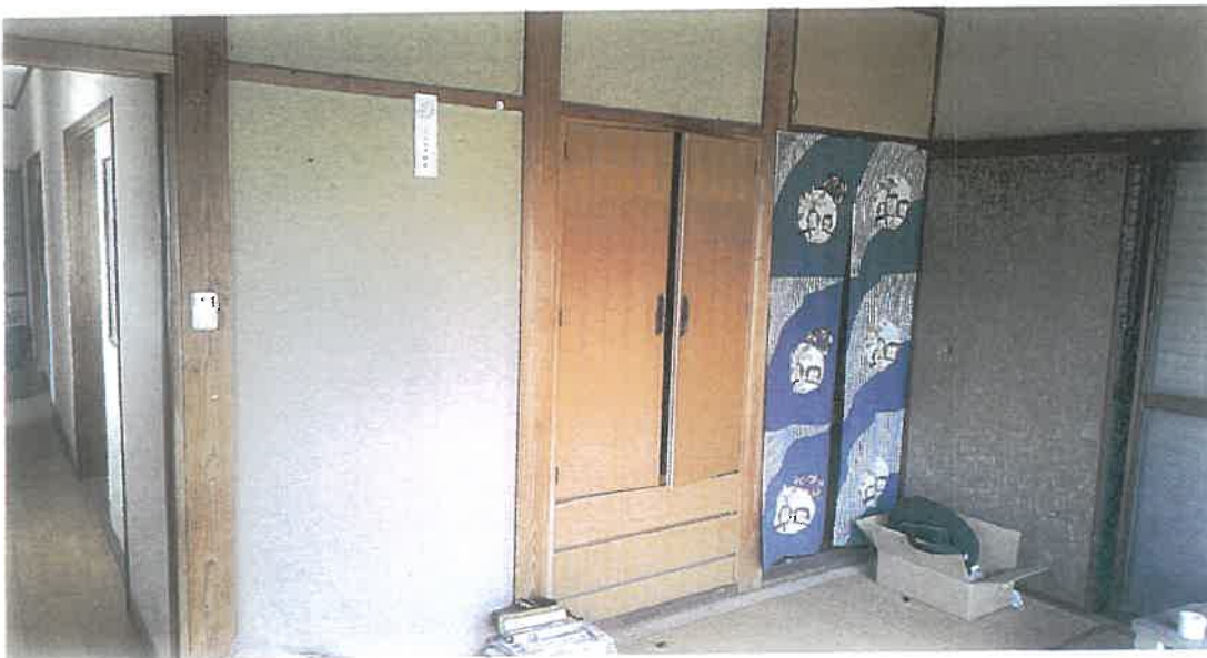
物件 2 内部状況
