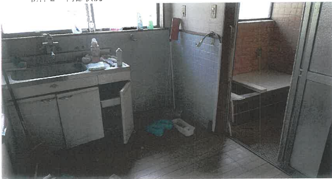
物件 2 内部状況
