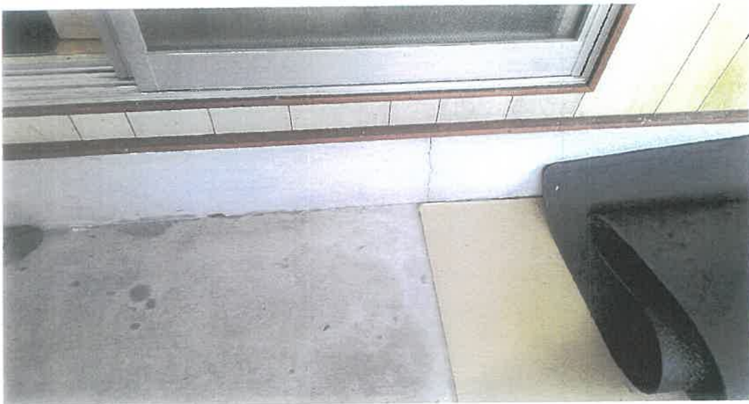
物件 3 内部状況
