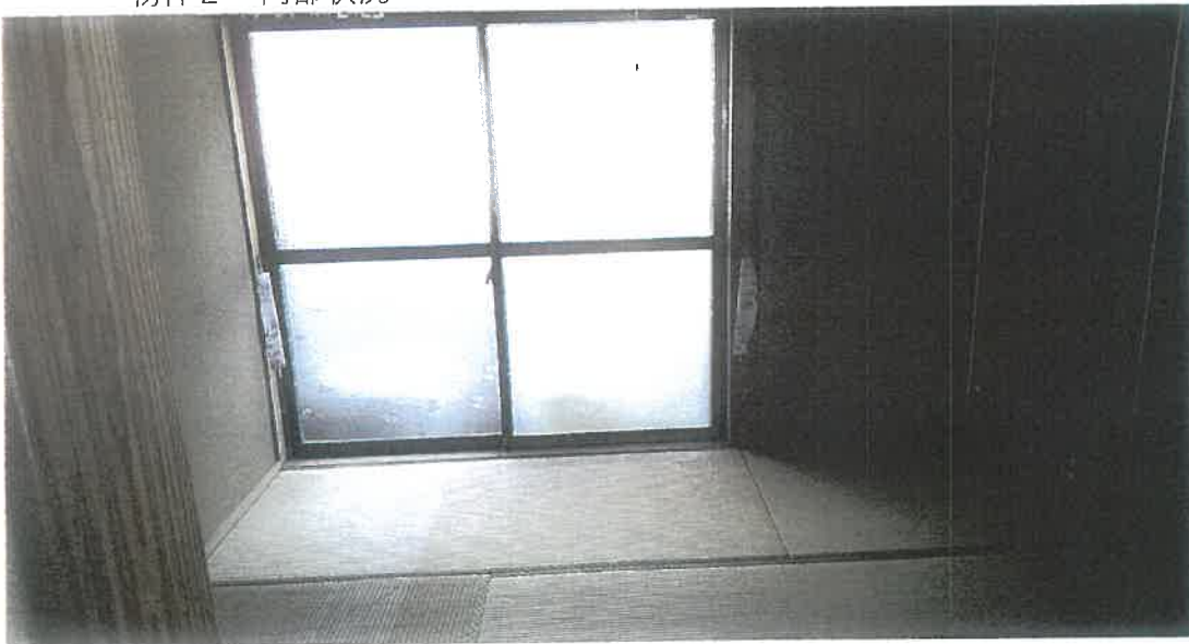
物件 2 内部状況
