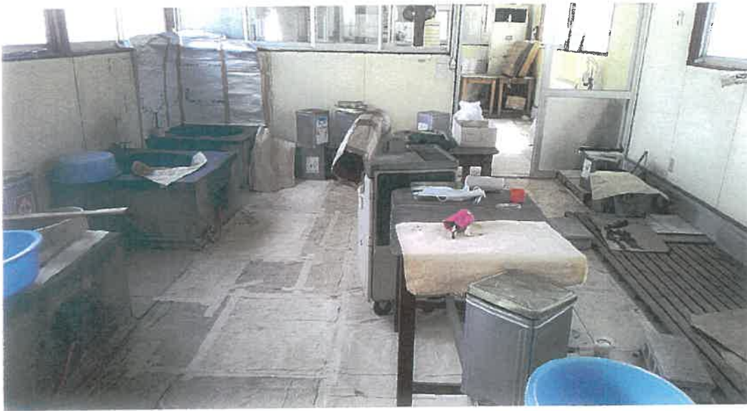
物件 3 内部状況
