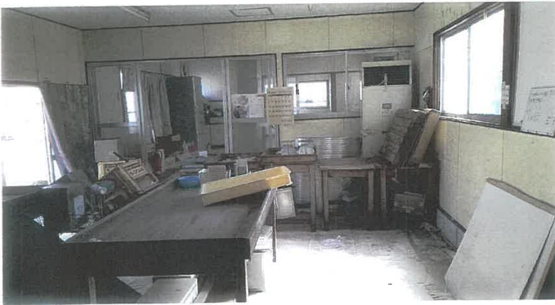
物件 3 内部状況
