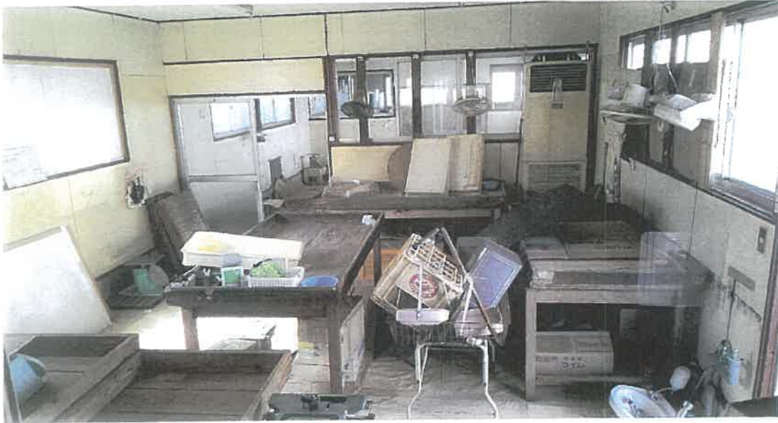
物件 3 内部状況
