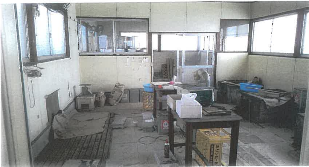
物件 3 内部状況
