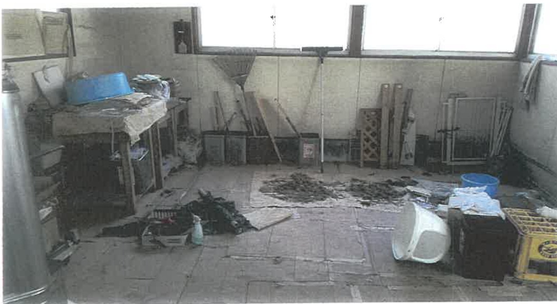
物件 3 内部状況
