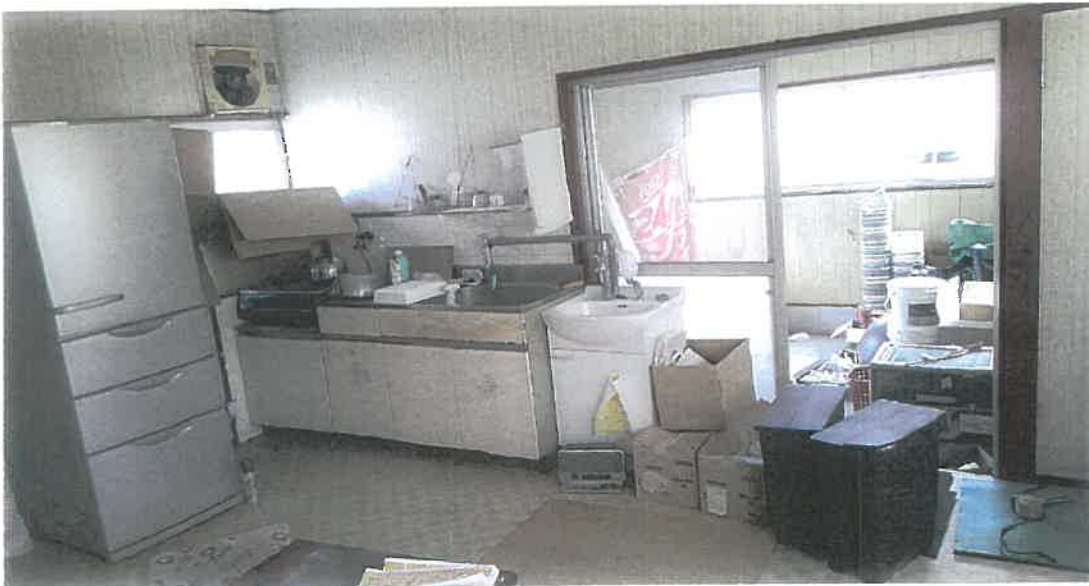
物件 3 内部状況
