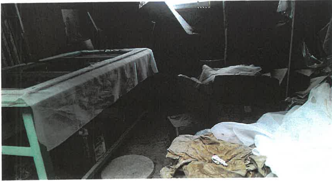
物件 3 未登記附属建物内部状況
