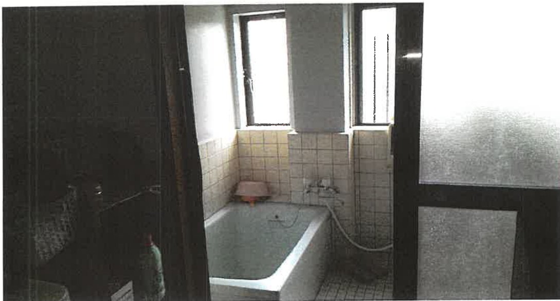
物件 3 2 階内部状況
