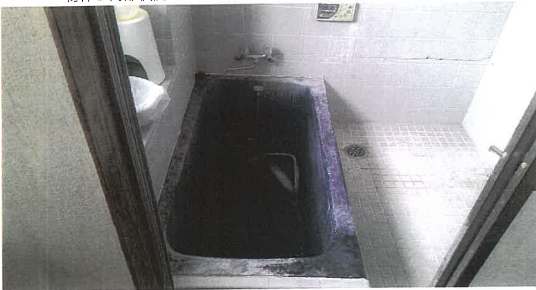
物件 2 内部状況
