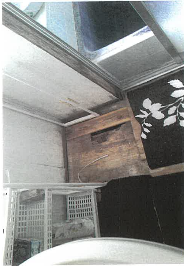
物件 2 内部状況
