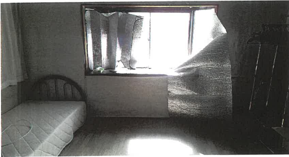
物件 2 内部状況
