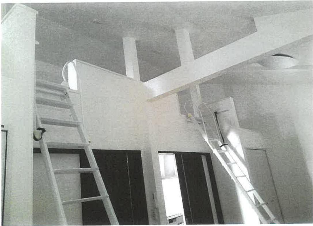
物件 5 内部状況
