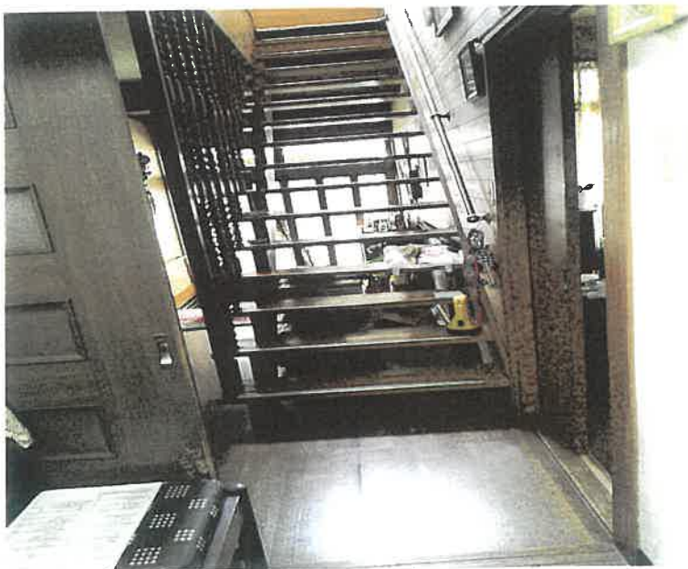
物件3 1階 内部状況
