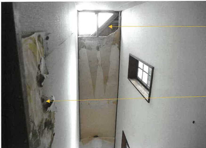
⑧階段天井
