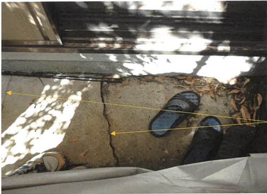
④本建物南側犬走り
