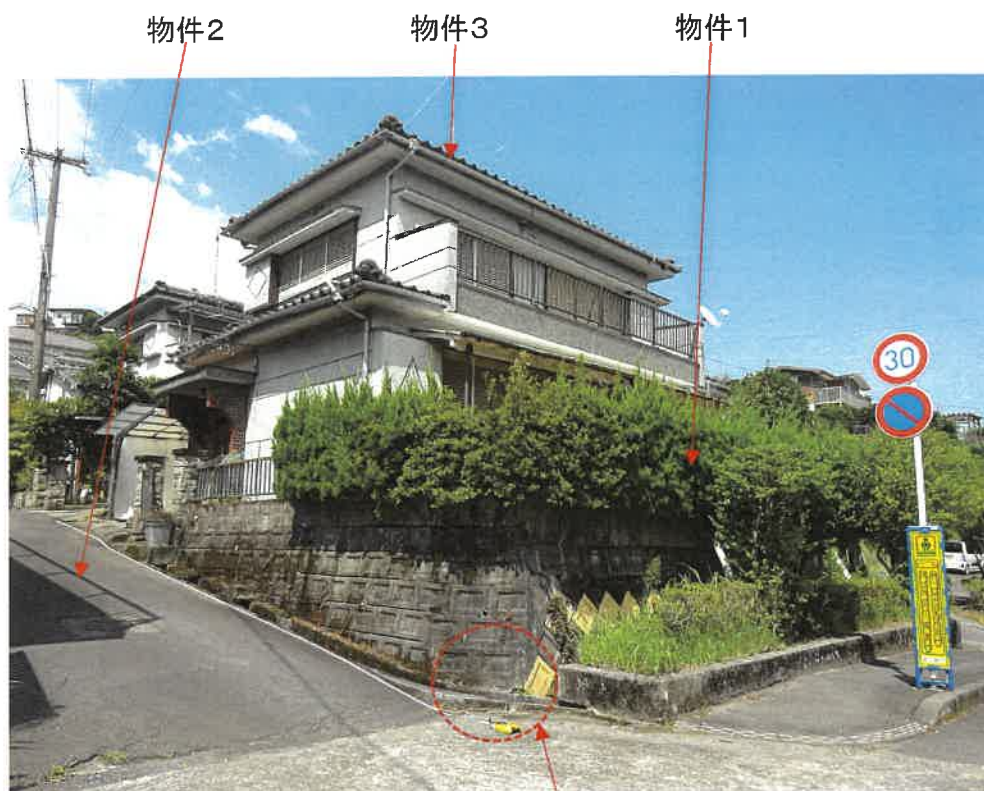
写真1 本件土地建物外観
