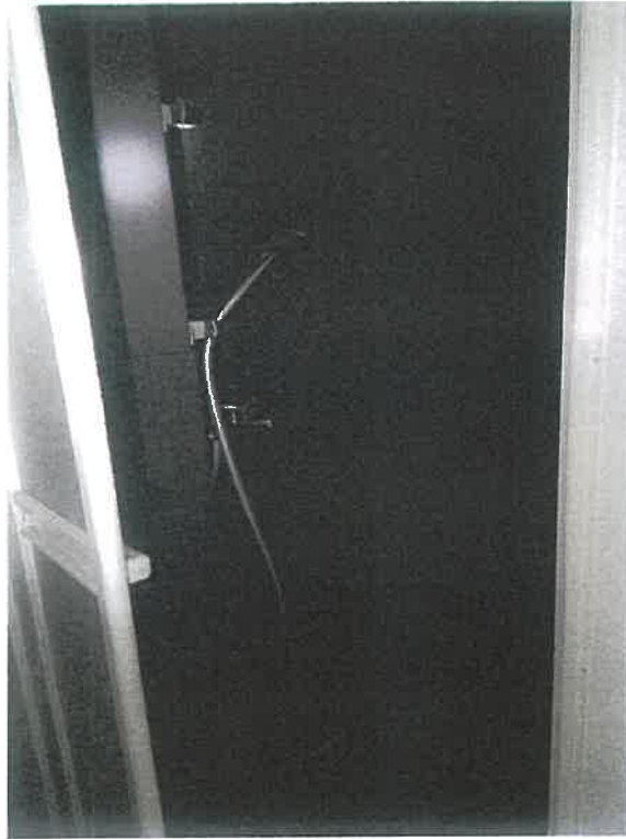
物件 1 内部状況
