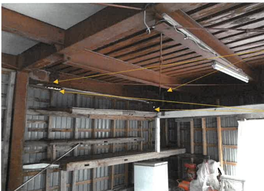
⑧本建物 1 階内部
